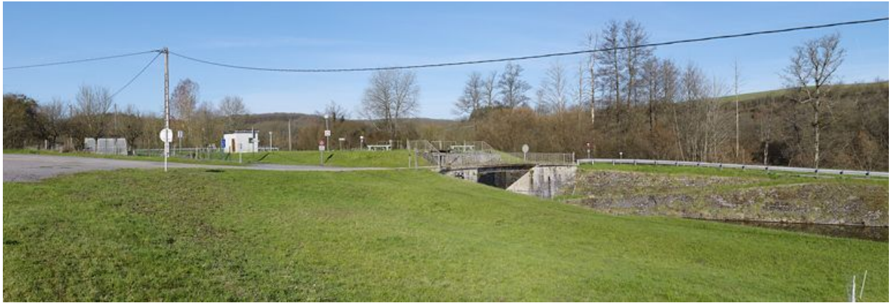
Vue d'ensemble du site d'écluse.
