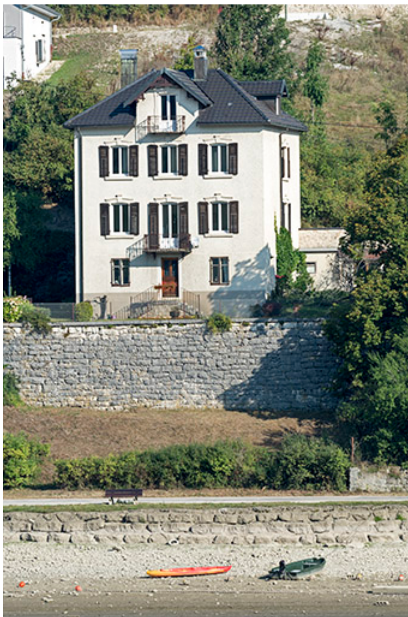
Vue d'ensemble, depuis le sud-est (façade postérieure).
