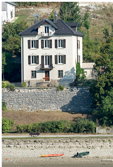
Vue d'ensemble, depuis le sud-est (façade postérieure).
