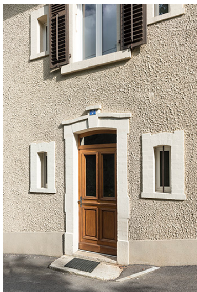
Façade antérieure : entrée.
