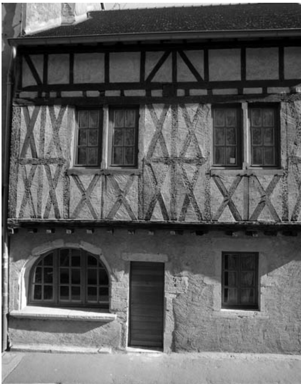
Façade antérieure : détail des pans de bois.
