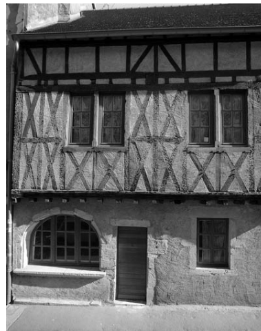
Façade antérieure : détail des pans de bois. Phot. Yves Sancey IVR43_19897000202X
