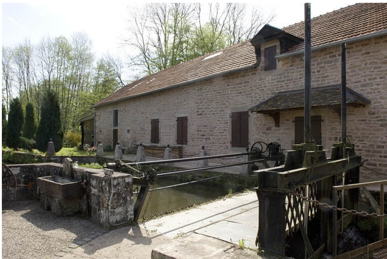
Logement (rive gauche) depuis l'est.
