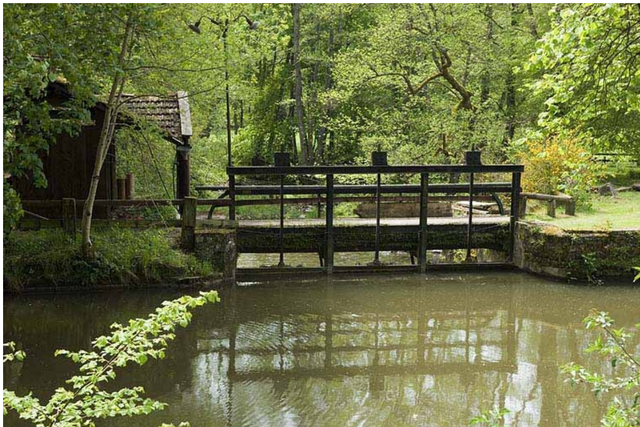
Vannes de décharge sur le bief d'amenée.
