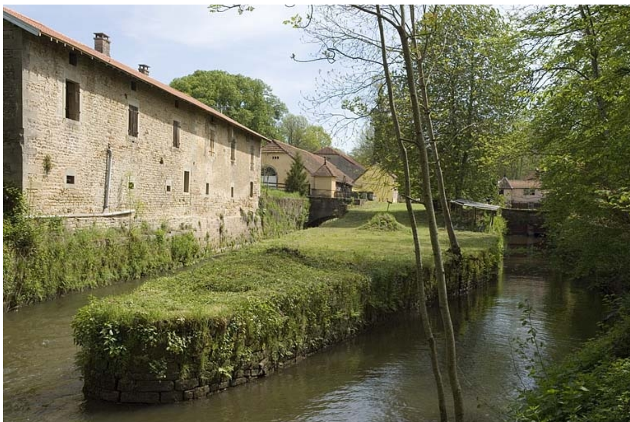
Vue d'ensemble depuis l'ouest.
