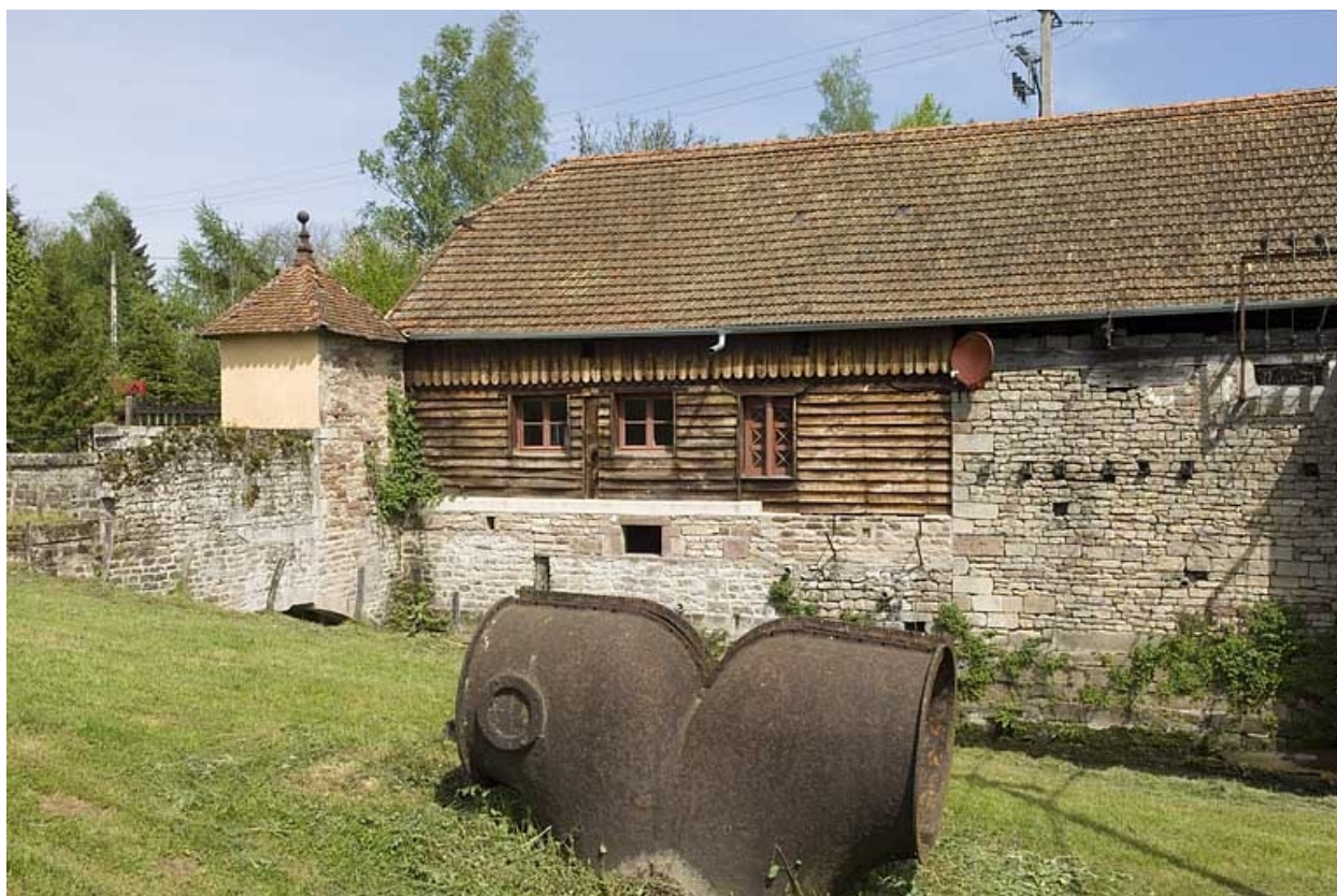
Façade sud de l'atelier de fabrication.
