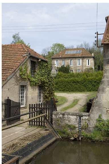
Logement patronal vu depuis le sud. Phot. Jérôme Mongreville IVR43_20067000305NUCA
