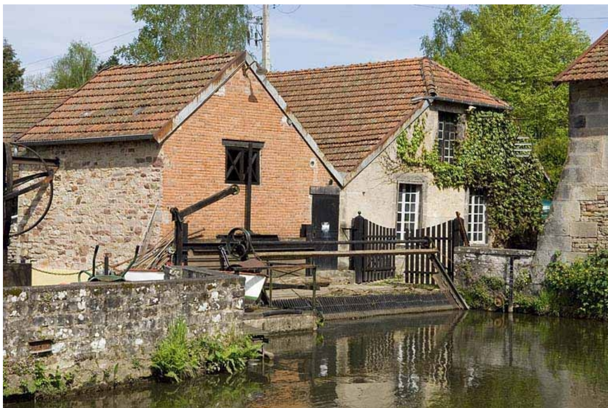
Salle des machines (nord).
