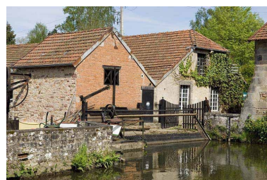
Salle des machines (nord). Phot. Jérôme Mongreville IVR43_20067000289NUCA
