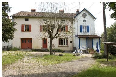
Logement de la centrale hydroélectrique. Phot. Jérôme Mongreville IVR43_20067000310NUCA
