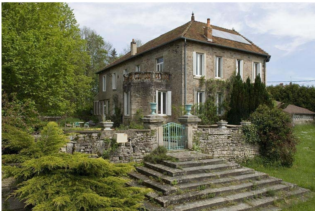
Logement patronal vu de trois quarts.
