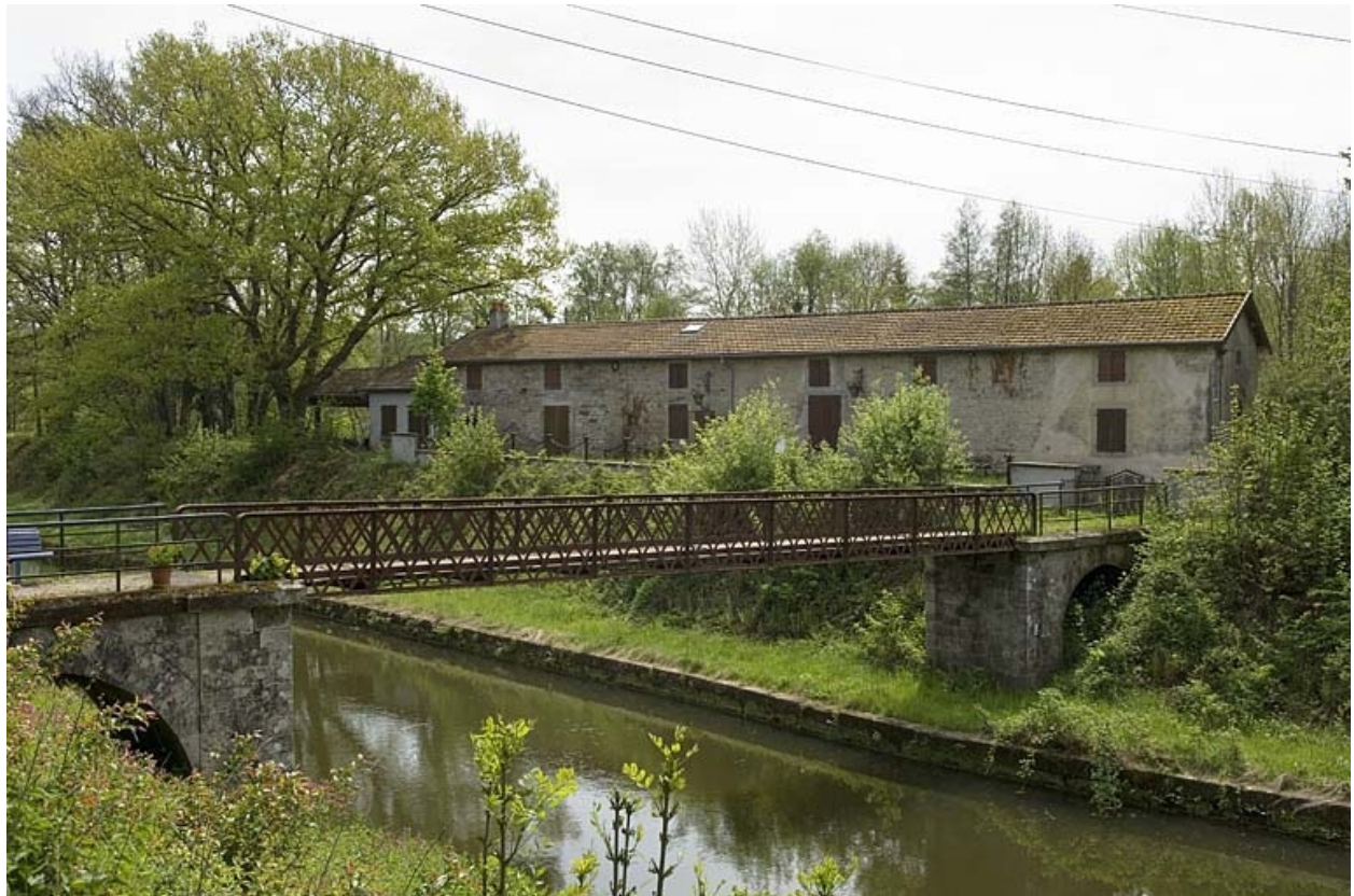
Vue d'ensemble du logement ouvrier collectif (est).
