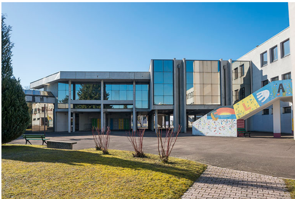
Façade nord du bâtiment d'accueil.
