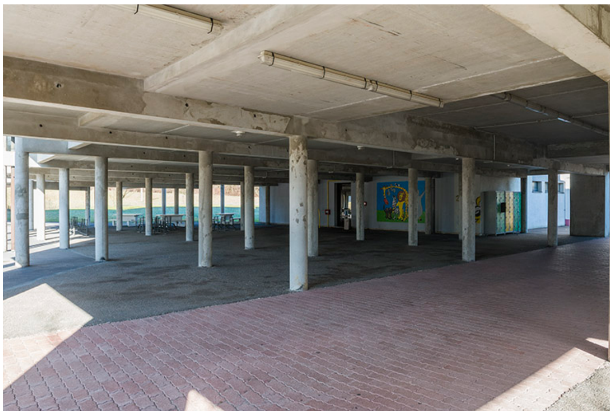
Préau sous le bâtiment d'accueil.
