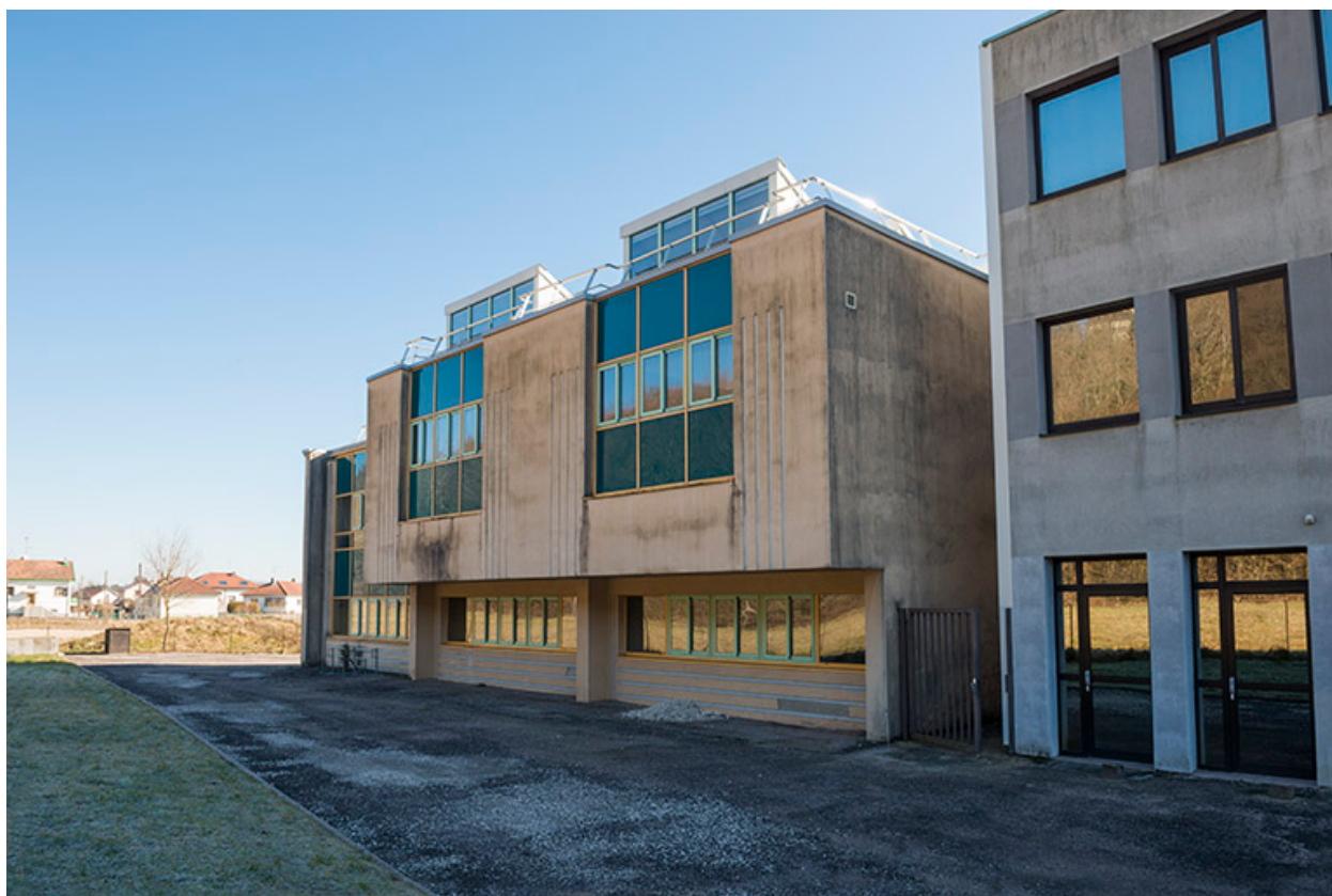
Façade ouest de l'externat nord.
