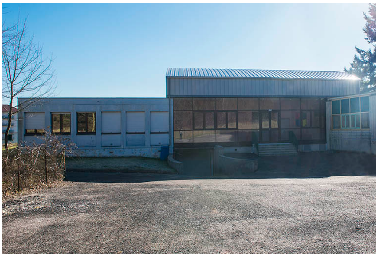
Façade nord-ouest de l'atelier
