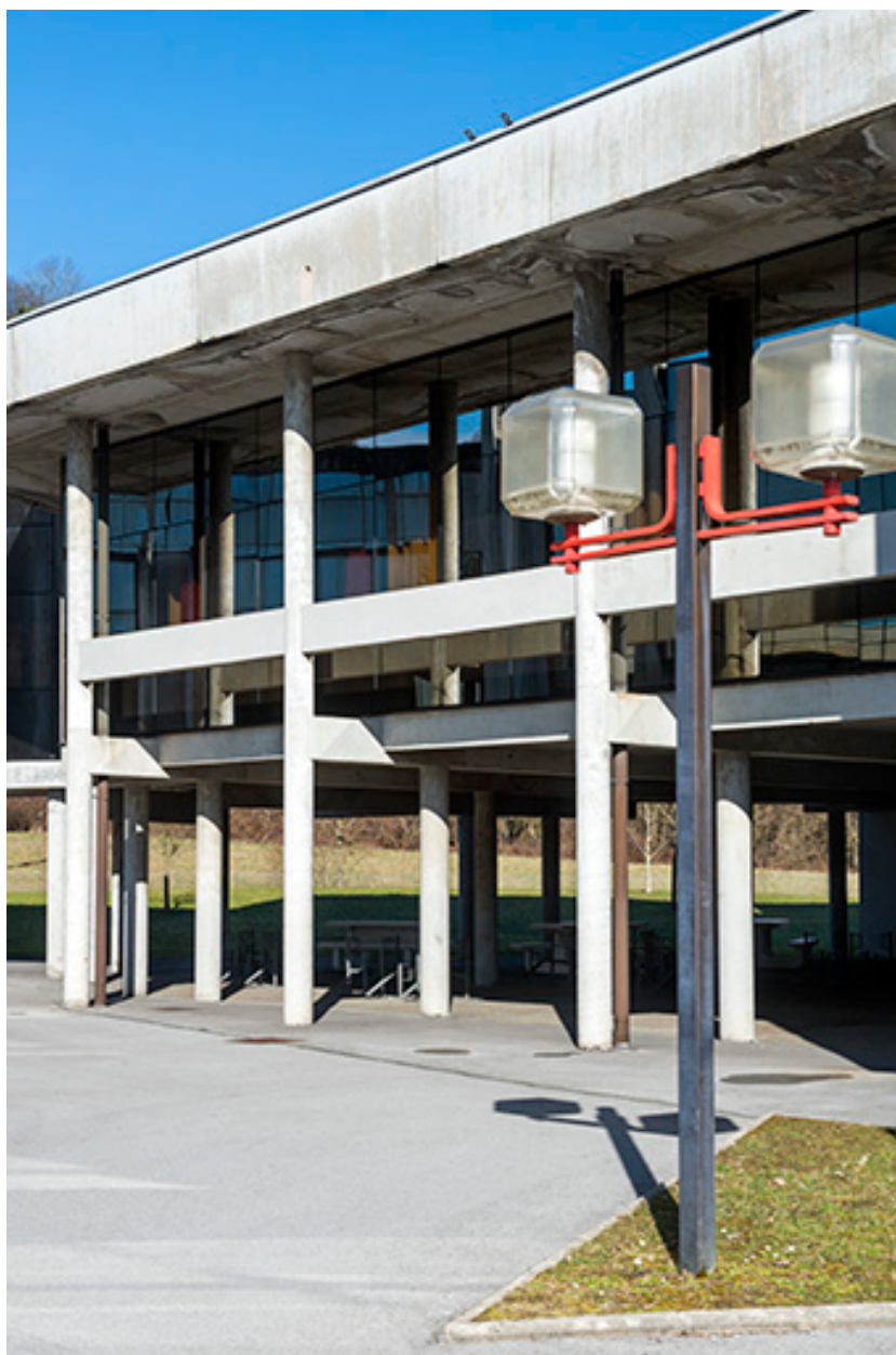
Détail de préau sous le bâtiment d'accueil.
