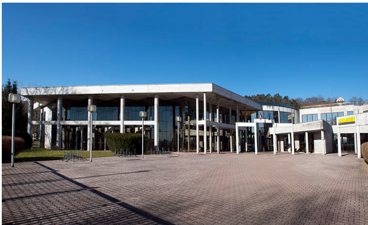
Cour d'accès et entrée depuis l'est.
