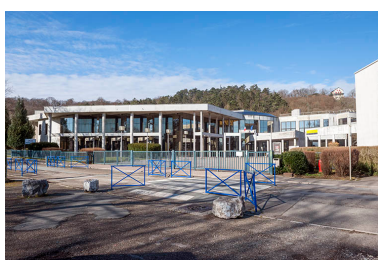
Vue de l'entrée depuis la rue des carrières. Phot. Mary Ruffinoni IVR43_20152500215NUC4A
