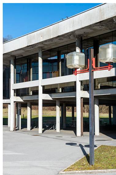
Détail de préau sous le bâtiment d'accueil.
