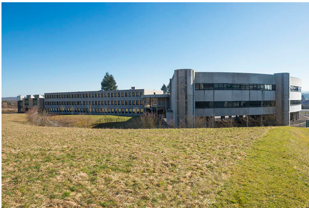
Vue d'ensemble des façades ouest.
