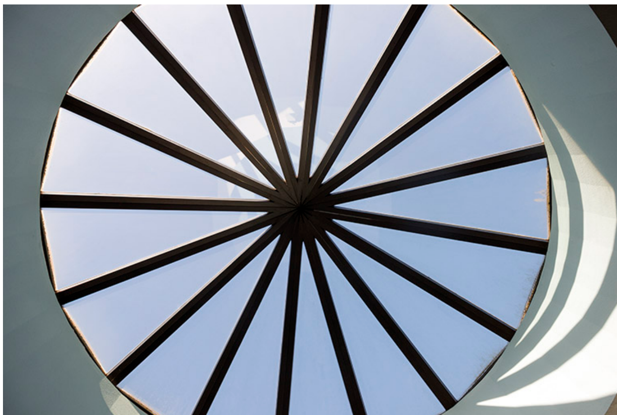
Détail intérieur de l'oculus zénithal du hall.
