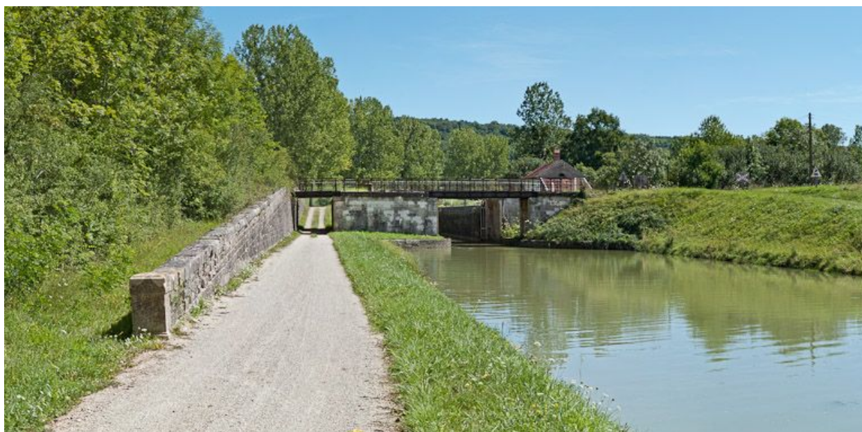
Vue du pont ferroviaire depuis l'aval.
