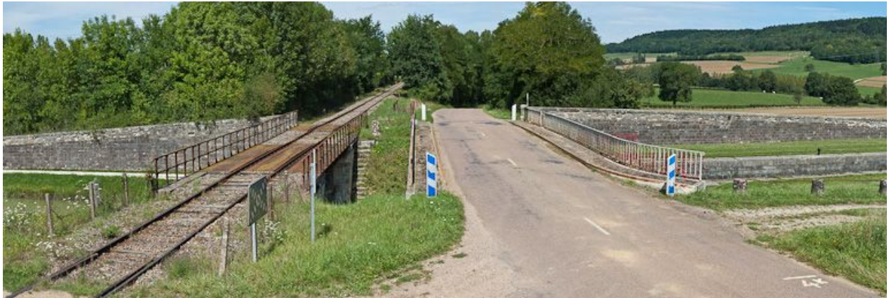
Vue des deux ponts sur écluse.
