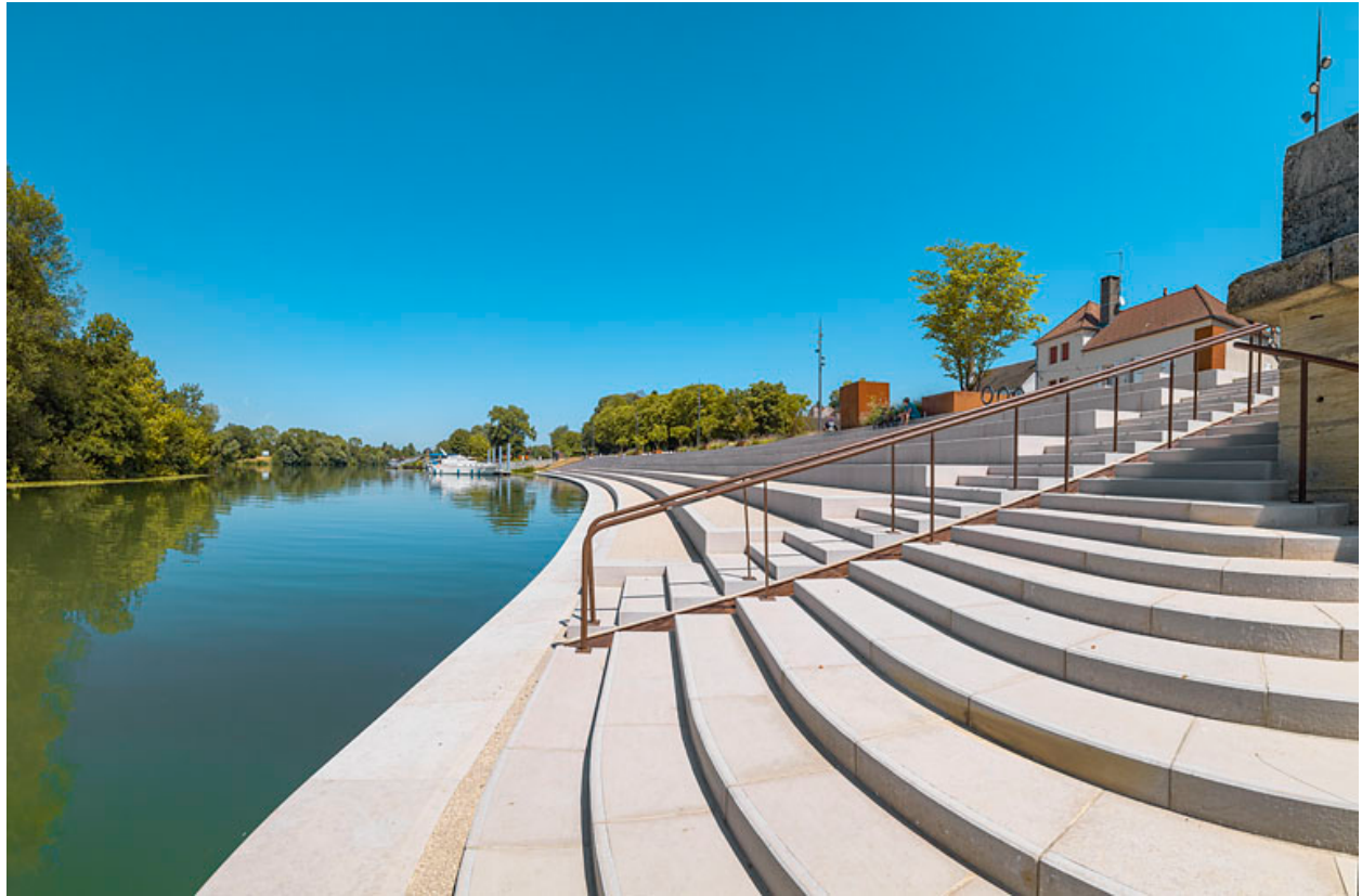
Vue d'ensemble des quais après leur réaménagement.
