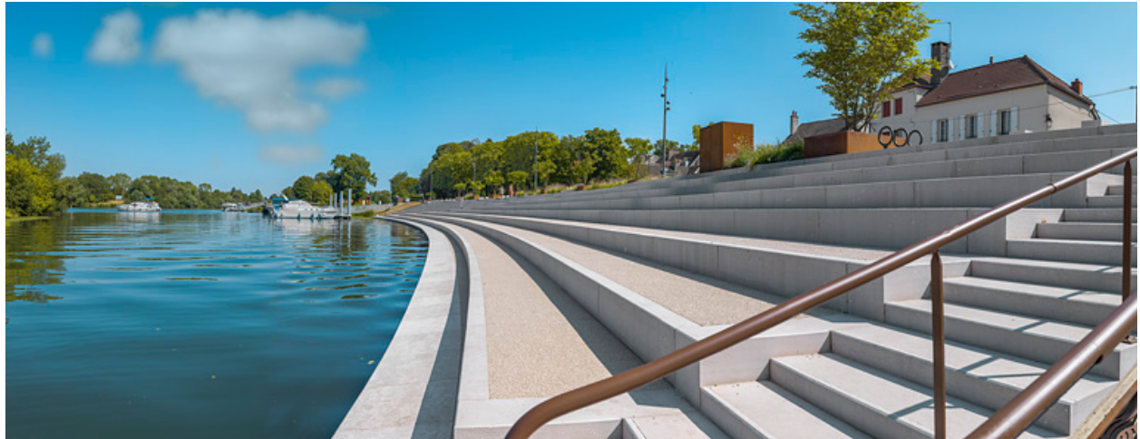
Vue d'ensemble des quais après leur réaménagement.
