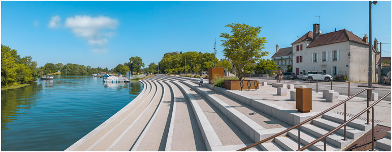
Vue d'ensemble des quais après leur réaménagement.
