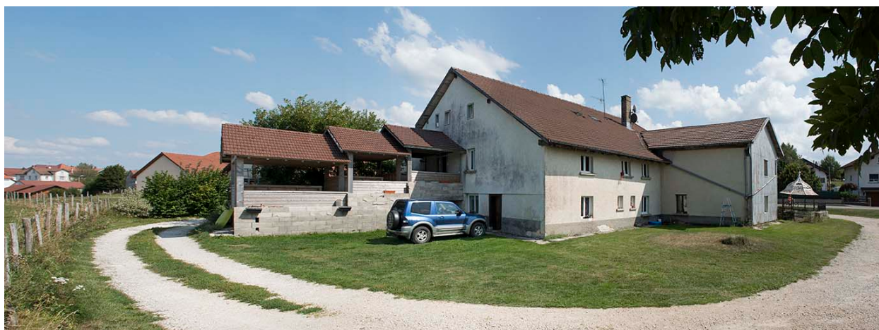
Façades postérieure et latérale gauche.
