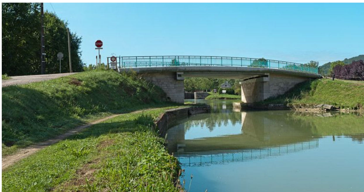
Vue du pont.
