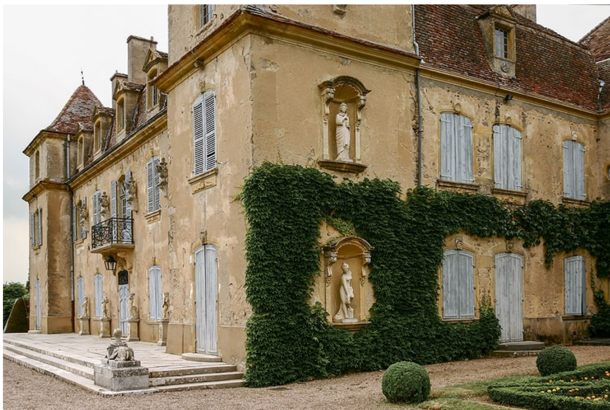
Vue des façades sud et est.
