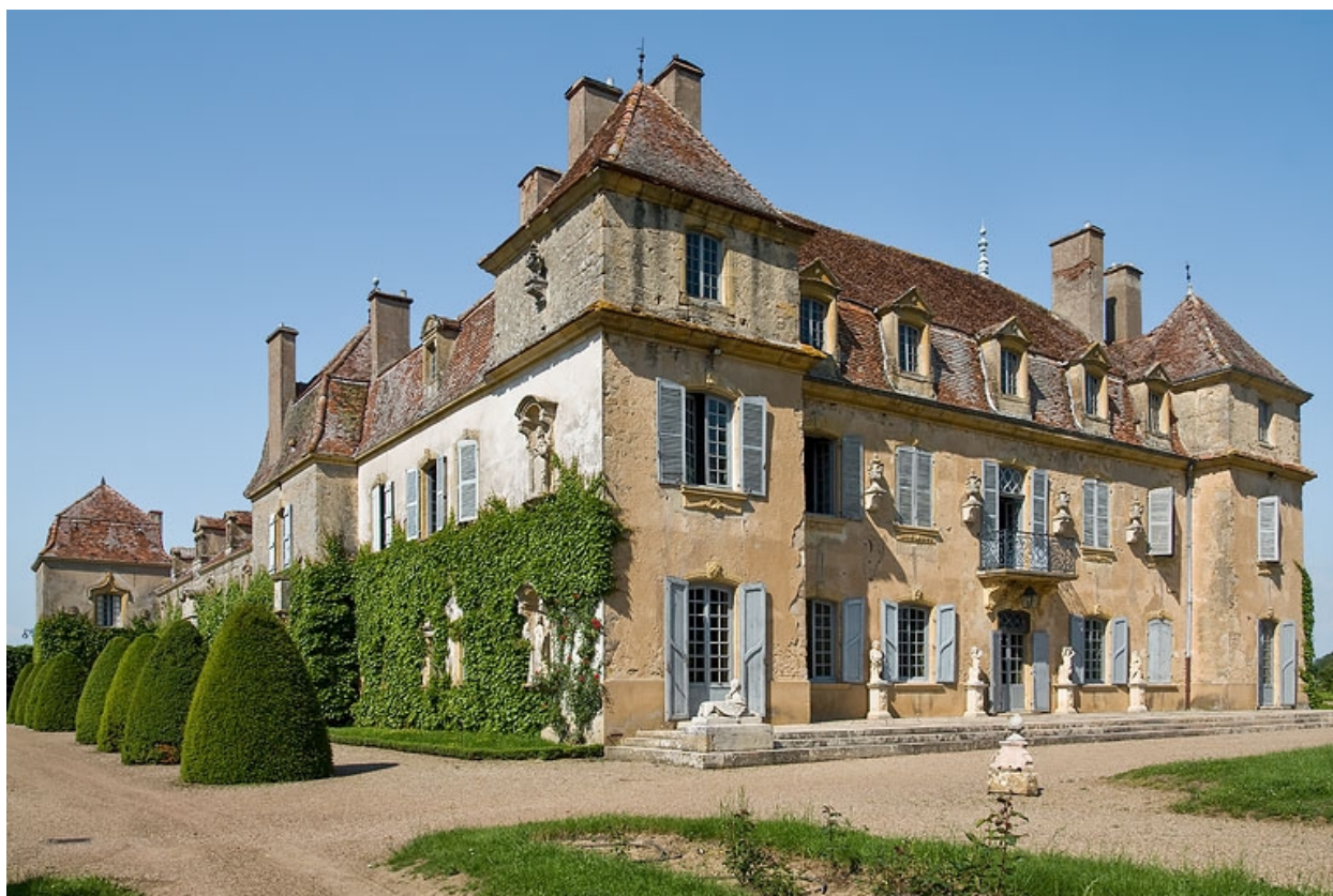
Vue des façades sud et ouest
