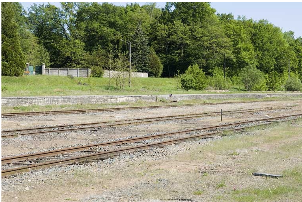
Gare de Port-d'Atelier : quai de la voie XIV.
