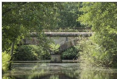
Pont à trois arches sur la Noue Rouge. Phot. Marc Loukachine IVR43_20127000193NUC2A
