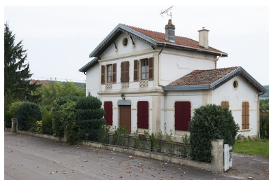
Gare de Faverney (ligne Nancy- Gray), 7 avenue de la Gare. Phot. Jérôme Mongreville IVR43_20127000633NUC4A
