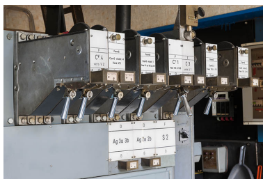
Gare de Port-d'Atelier, poste d'aiguillage : manettes de commande de la signalisation. Phot. Jérôme Mongreville IVR43_20127000569NUC4A
