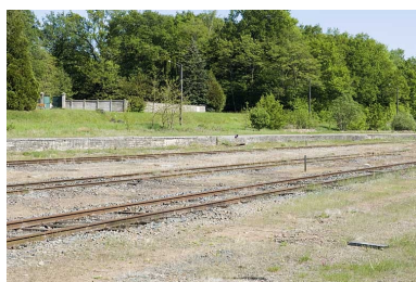
Gare de Port-d'Atelier : quai de la voie XIV. Phot. Marc Loukachine IVR43_20127000173NUC2A
