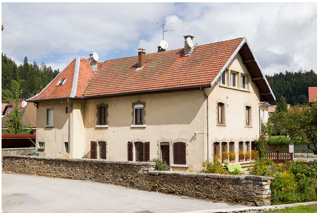
Façades postérieure et latérale gauche.
