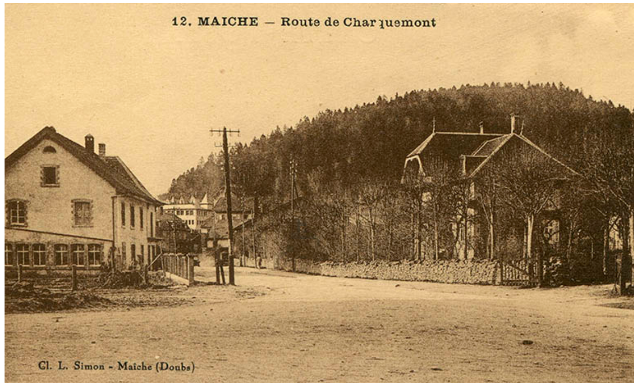
12. Maîche - Route de Charquemont [au niveau des n° 2 et 5 rue Sainte-Anne], 1ère moitié 20e siècle (avant 1936).
