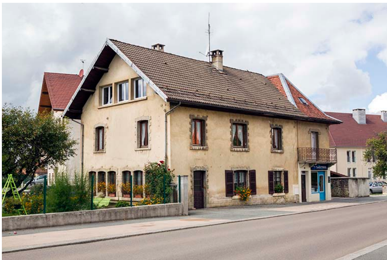
Façades antérieure et latérale gauche.
