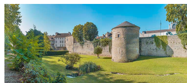
Vue générale. Phot. Thierry Kuntz IVR26_20232100364NUC4A
