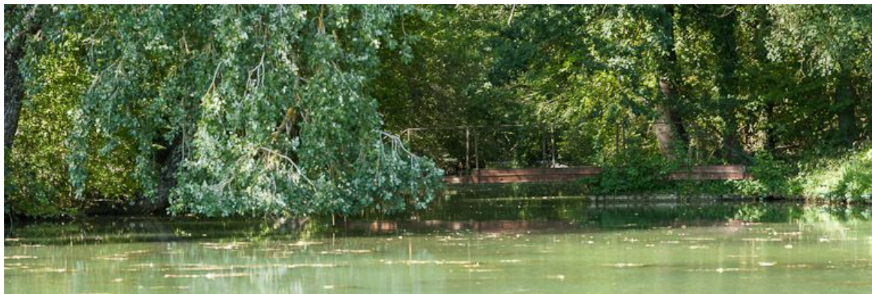
Passerelle sur le chenal d'accès au port des Forges.
