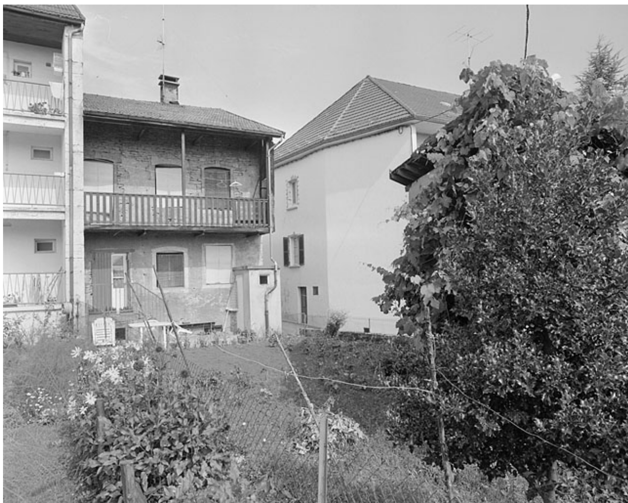
Façade postérieure avec balcon en galerie.
