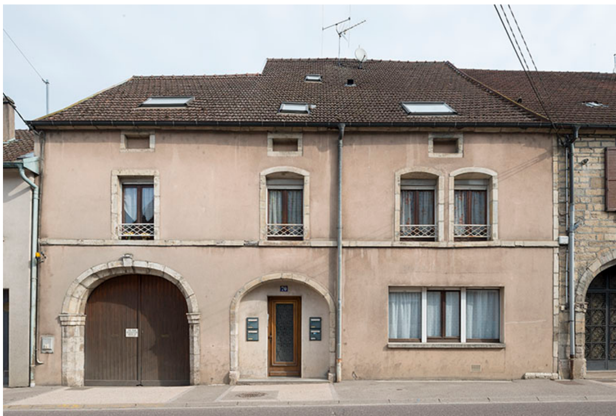
Maison transformée, rue François Mitterrand.
