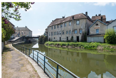
Le bief et l'île de l'ancien château. Phot. Jérôme Mongreville IVR43_20177000703NUC4A
