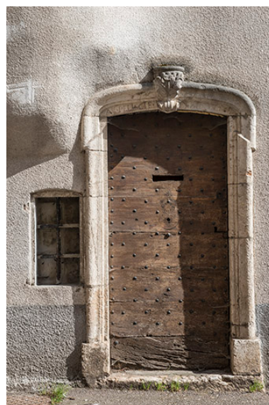
Porte avec linteau en arc surabaissé. Phot. Jérôme Mongreville IVR43_20177000514NUC4A
