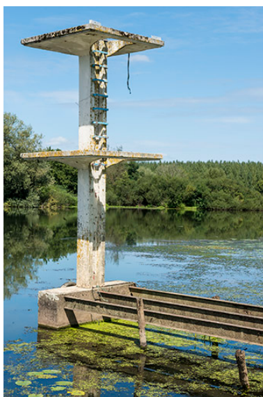
Le plongeur. Phot. Jérôme Mongreville IVR43_20177001048NUC4A
