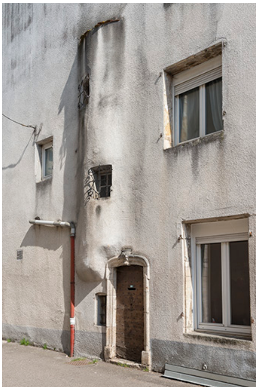
Maison à tour, rue Jean Bogé.
