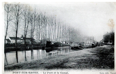
La canal et le port, carte postale. Autr. auteur inconnu IVR43_20177000904NUC1A
