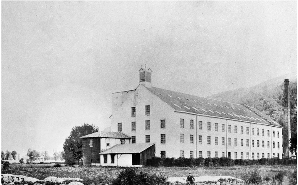
Vue d'ensemble de la filature.
