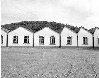
Murs-pignons de l'atelier de fabrication.
