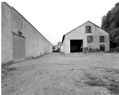
Façade postérieure de la salle des machines.
