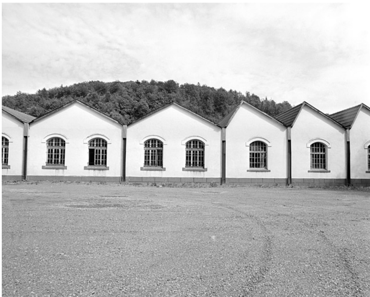
Murs-pignons de l'atelier de fabrication.
