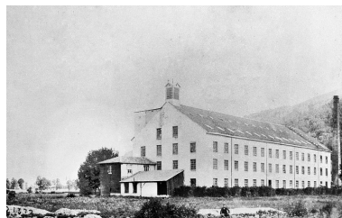
Vue d'ensemble de la filature. Phot. Jérôme Mongreville IVR43_20019000138X
