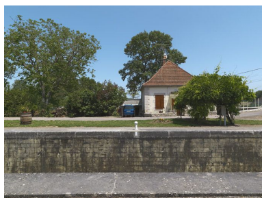
Maison éclusière vue de face. Phot. Thierry Kuntz IVR26_20112103260NUC4A
