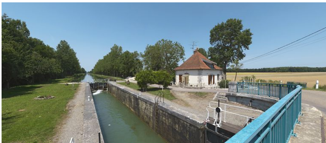
Vue d'ensemble du site prise d'aval.
