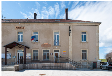
Façade nord (partie fromagerie). Phot. Jérôme Mongreville IVR43_20162500321NUC4A
