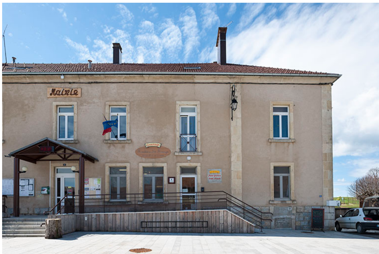
Façade nord (partie fromagerie).
