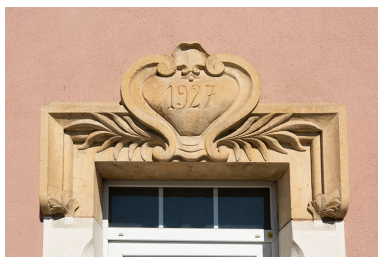
Façade antérieure : linteau daté 1927. Phot. Sonia Dourlot IVR43_20182501002NUC4A
