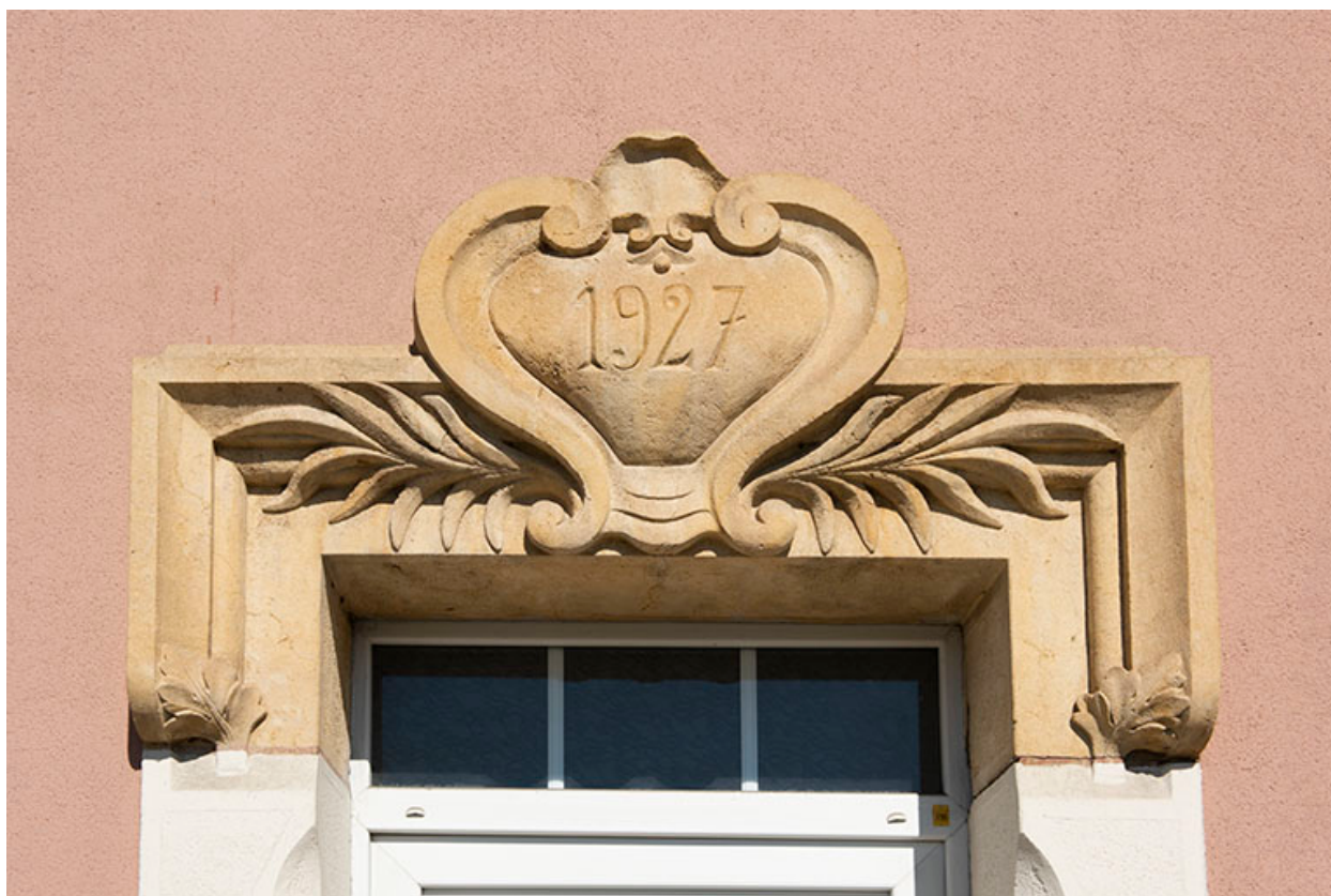
Façade antérieure : linteau daté 1927.
