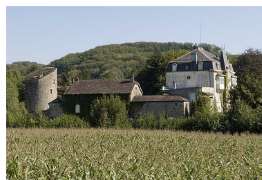
Logement patronal depuis le nord-ouest.
