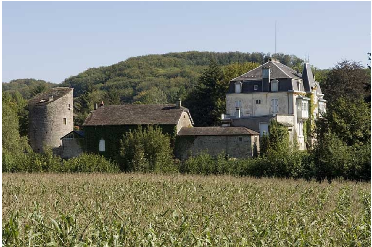
Logement patronal depuis le nord-ouest.
