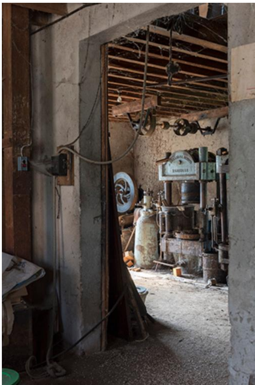
Vue du rez-de-chaussée depuis le magasin
