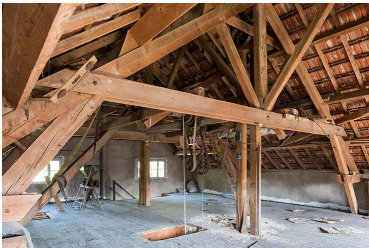
Vue d'ensemble de l'étage en surcroît
