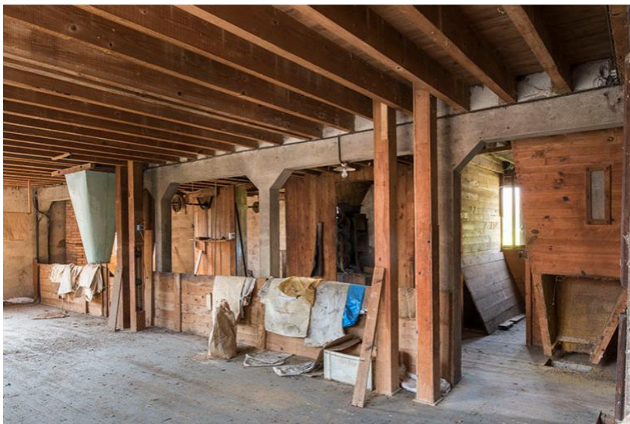
Vue d'ensemble du premier étage
