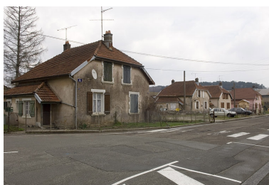
Logements ouvriers doubles rue Paul Vinot. Phot. Jérôme Mongreville IVR43_20067000110NUCA
