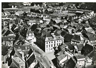
Vue aérienne depuis le nord-ouest. Phot. Jérôme Mongreville IVR43_20067000211NUCA
