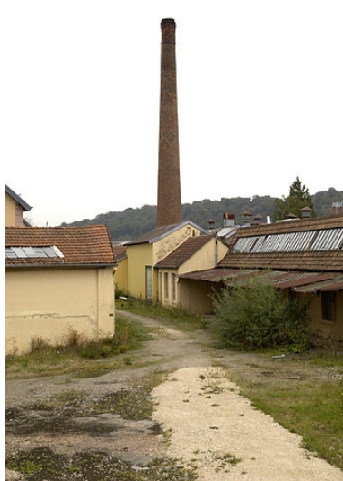
Atelier et cheminée depuis l'entrée. Phot. Jérôme Mongreville IVR43_20057000485NUCA
