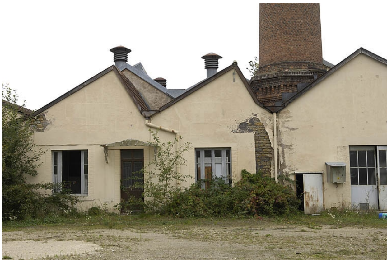
Bureau et chaufferie.
