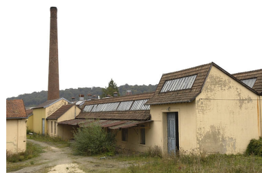
Cheminée et salle de réception. Phot. Jérôme Mongreville IVR43_20057000487NUCA
