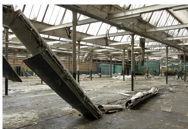
Extension est de la salle de tissage. Charpente métallique et sheds. Phot. Jérôme Mongreville IVR43_20057000473NUCA
