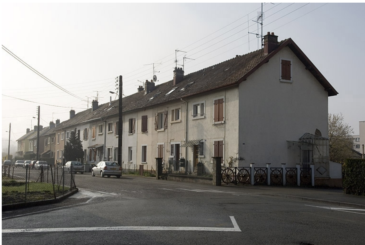
Logements ouvriers rue Paul Vinot.
