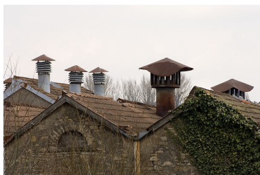
Cheminées métalliques de la salle de tissage. Phot. Jérôme Mongreville IVR43_20067000113NUCA
