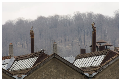
Détail des toitures et des cheminées métalliques. Phot. Jérôme Mongreville IVR43_20067000112NUCA
