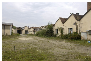
Murs-pignons nord de la salle de tissage. Phot. Jérôme Mongreville IVR43_20057000469NUCA
