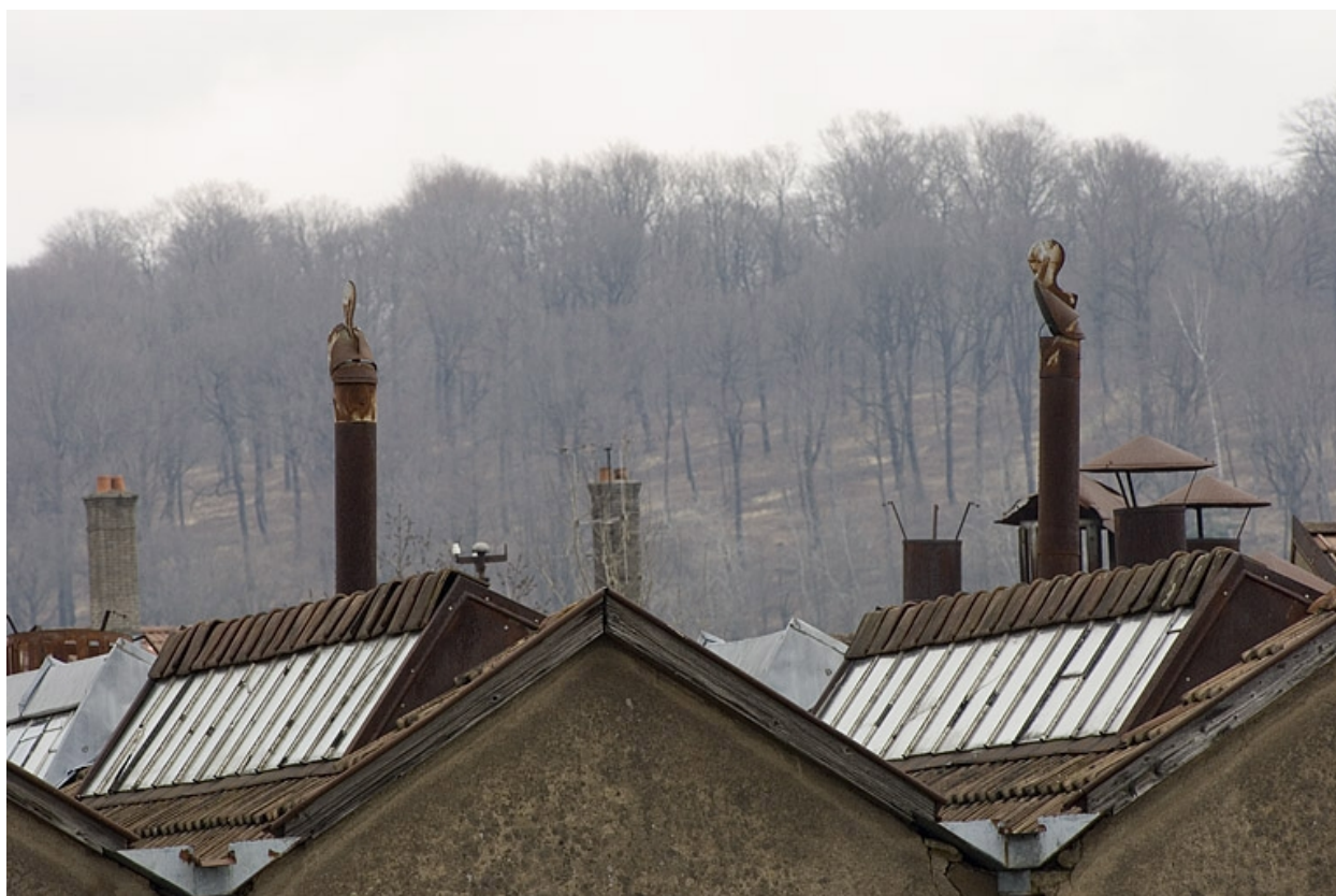
Détail des toitures et des cheminées métalliques.
