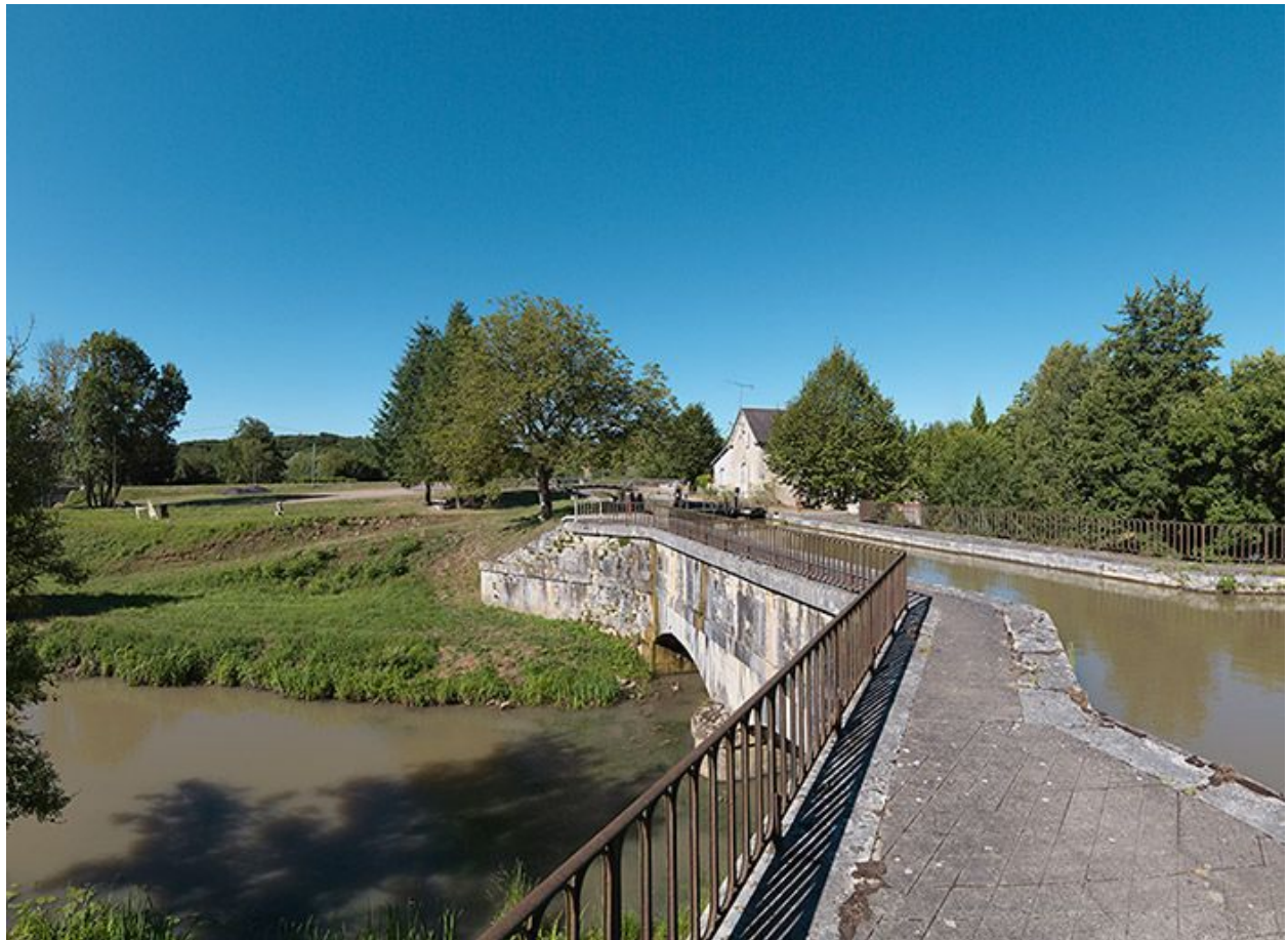
Vue d'ensemble du pont canal.
