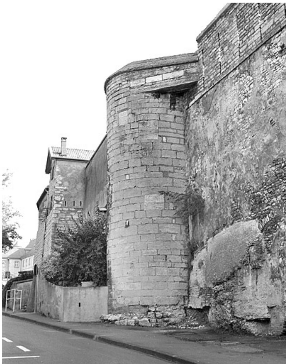
Enceinte. Tour de la porte (c).
