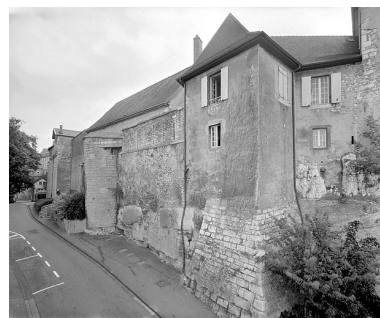
Enceinte. Partie près de la porte (d). Phot. Jérôme Mongreville IVR43_19872501153V
