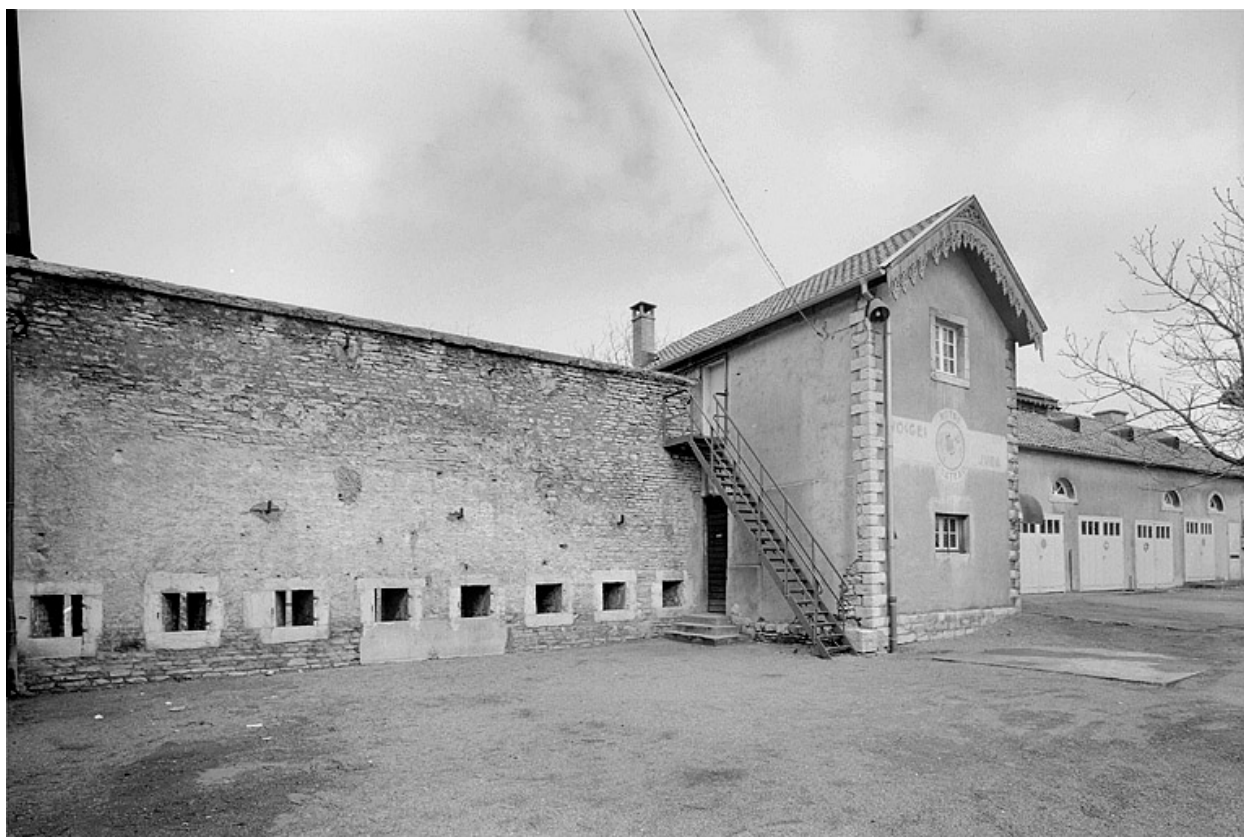
Enceinte. Partie vue de la basse-cour (p).
