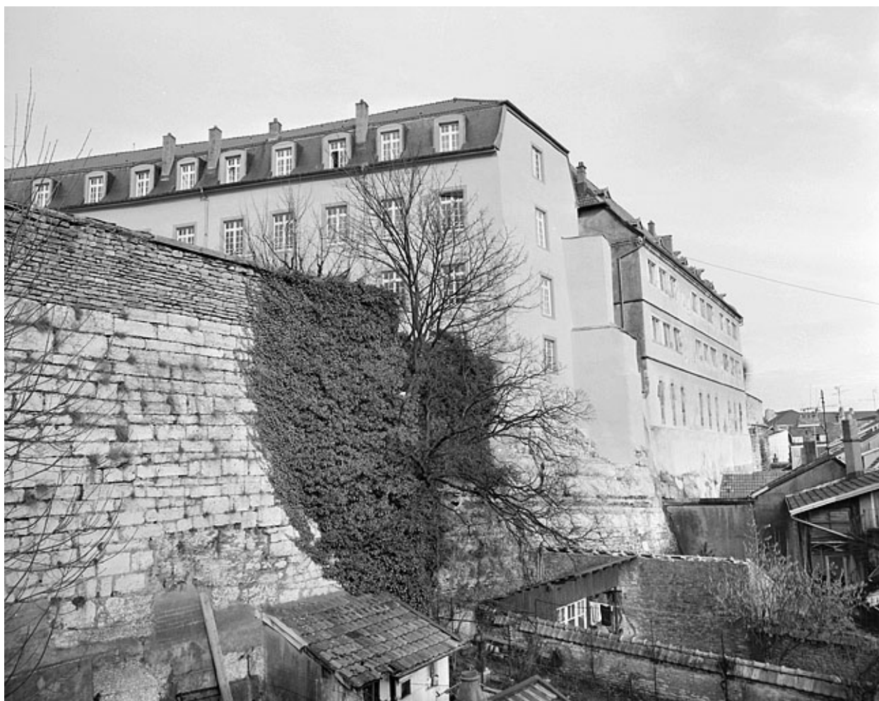
Enceinte. Partie sous le Vieux Château (k).
