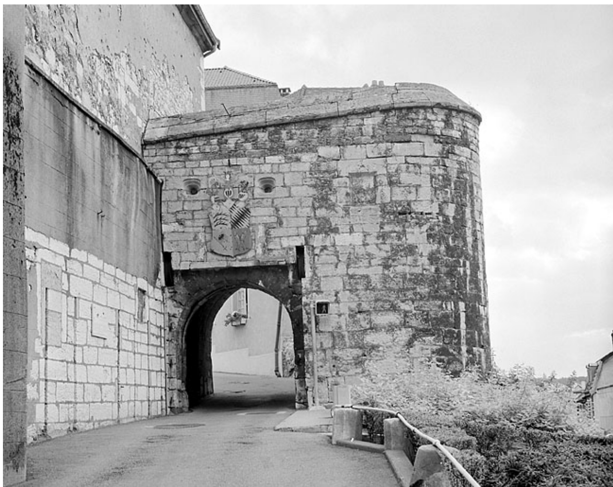
Enceinte. Porte (a).
