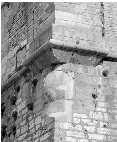
Enceinte. Blason bûché sous le Neuf Château (1). Phot. Jérôme Mongreville IVR43_19882500102X
