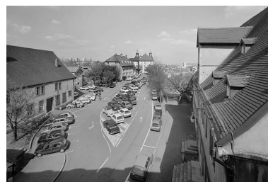
Vue d'ensemble de la basse- cour vers le Neuf Château. Phot. Jérôme Mongreville IVR43_19882500084V
