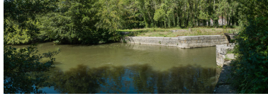
Vue du barrage.
