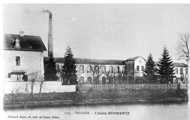
Valdoie. - L'usine Schwartz. Phot. Jérôme Mongreville IVR43_20019000133X
