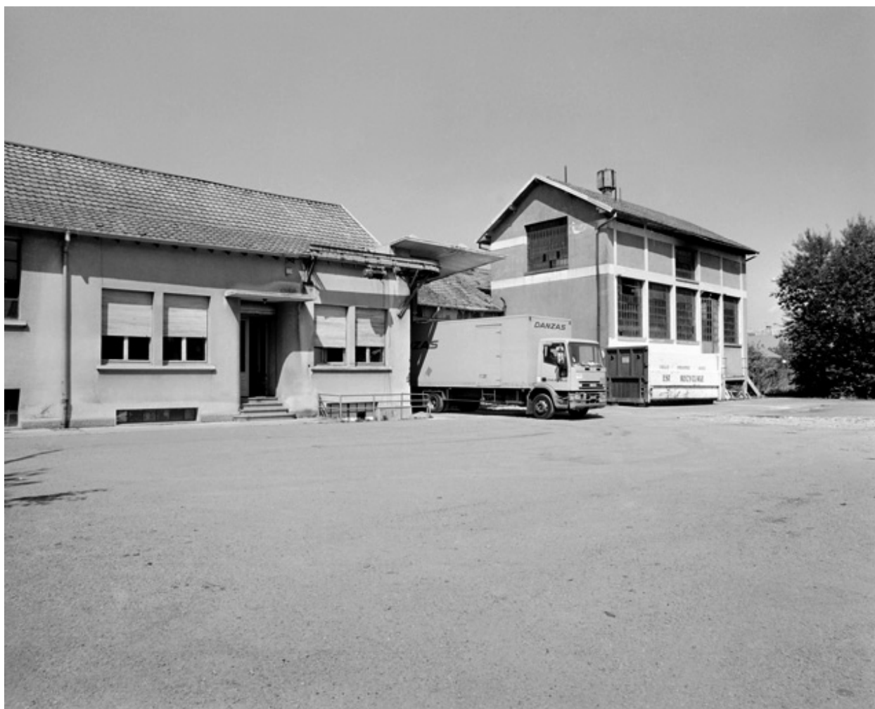
Façade sud et chaufferie.
