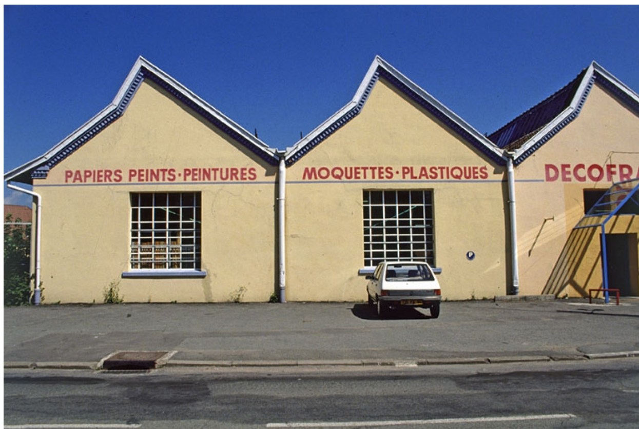
Pignons ouest de l'atelier de fabrication.
