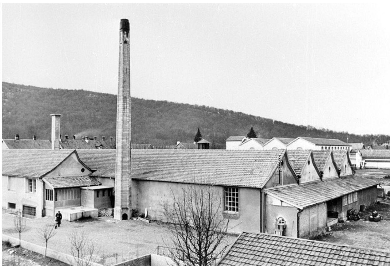
Vue d'ensemble depuis le sud-est vers 1945.
