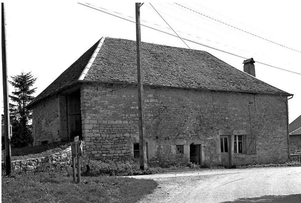
Ferme située rue Principale.
