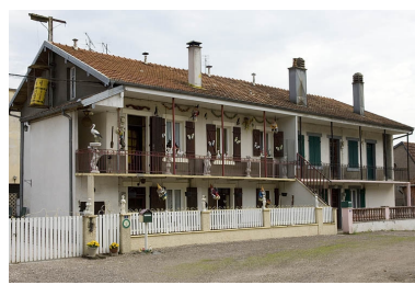
Logement ouvrier à étage (est). Phot. Jérôme Mongreville IVR43_20067000349NUCA
