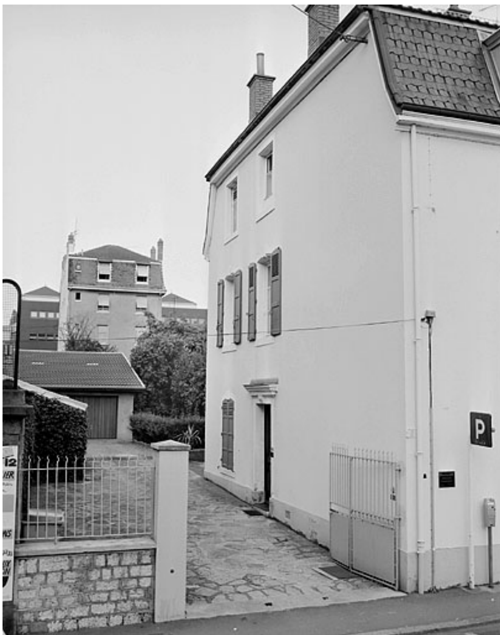
Façade latérale gauche du corps d'habitation.
