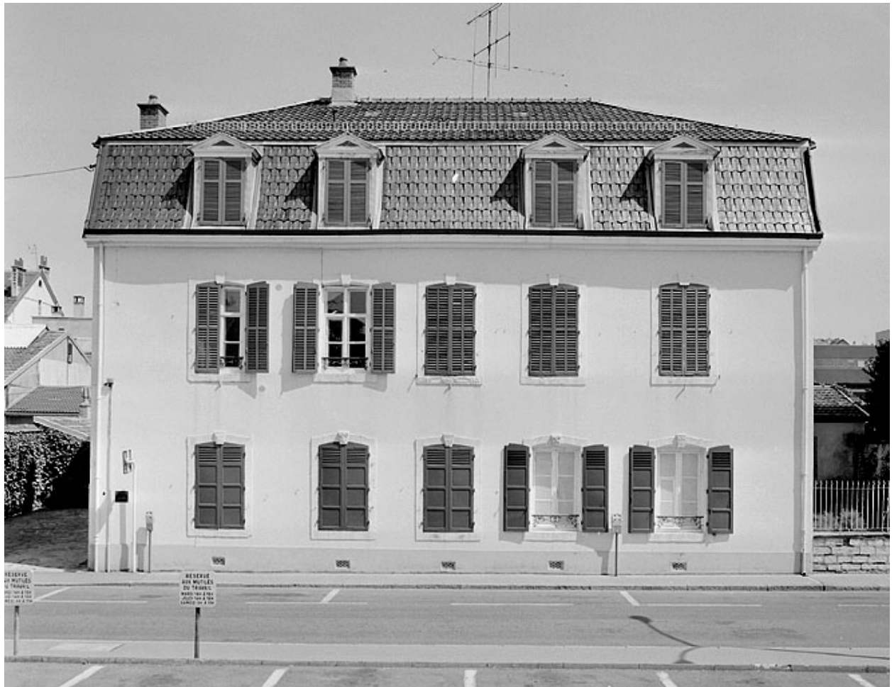
Façade sur rue du corps d'habitation.
