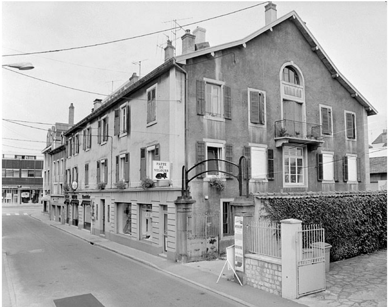
Immeuble occupant l'emplacement du bâtiment agricole.
