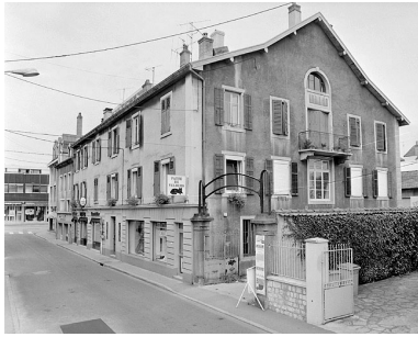
Immeuble occupant l'emplacement du bâtiment agricole. Phot. Jérôme Mongreville IVR43_19872500737X
