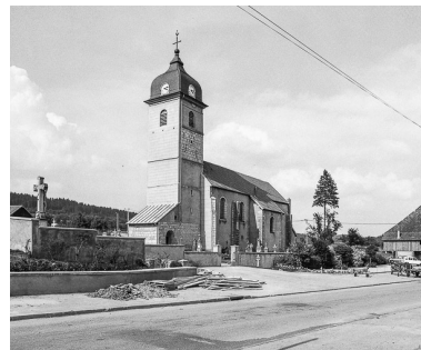
Extérieur : faces sud et ouest. Phot. Yves Sancey IVR43_19752500354X
