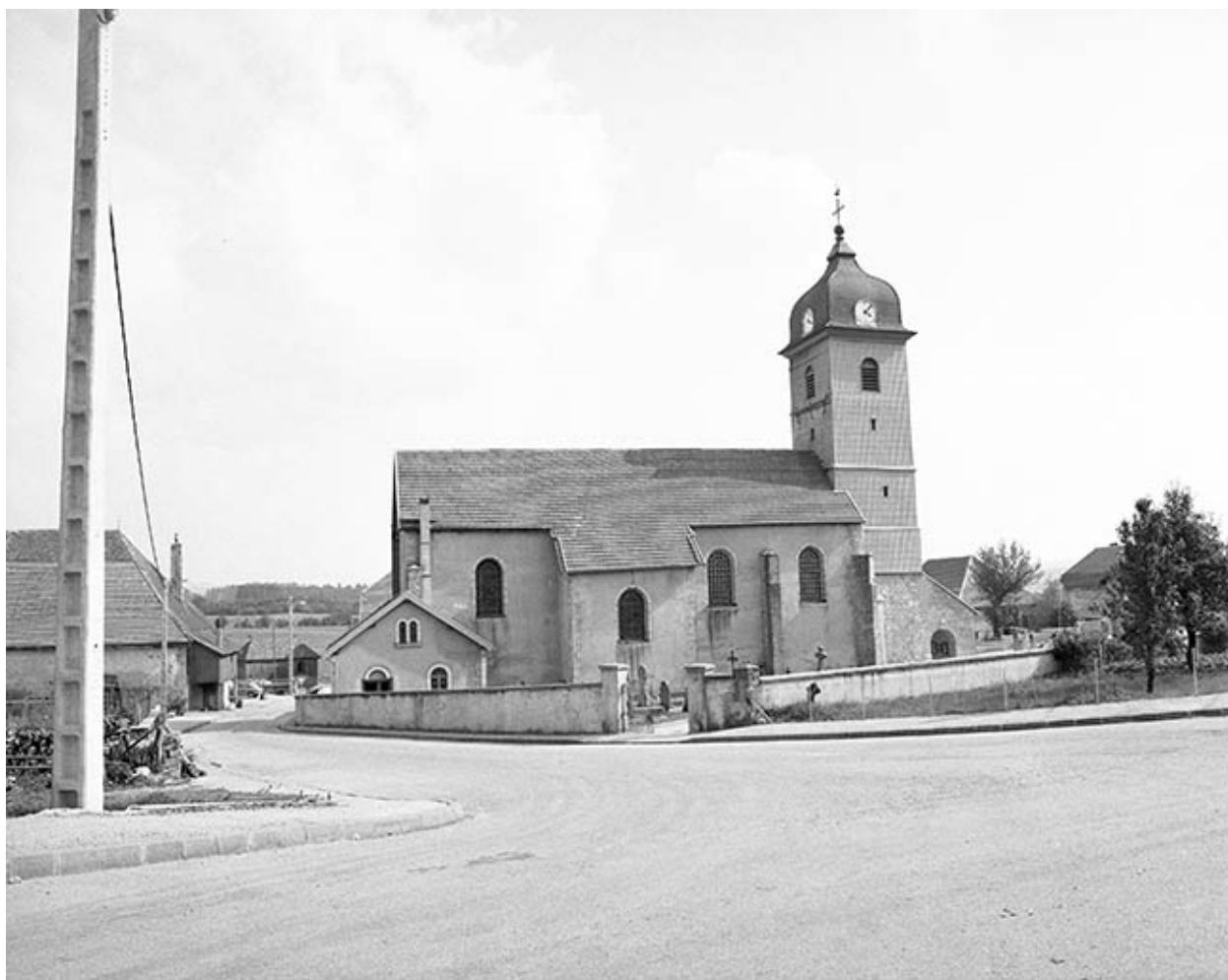
Extérieur : face latérale nord.
