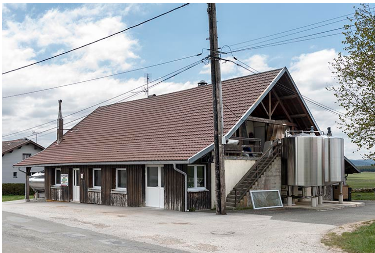
Façades postérieure et latérale droite.
