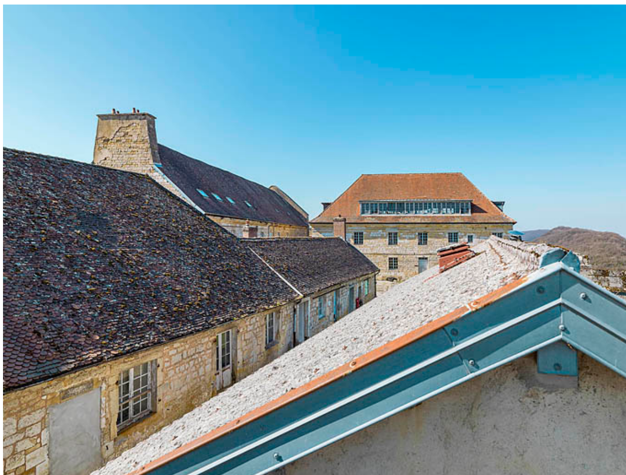
Toit à croupe du bâtiment.
