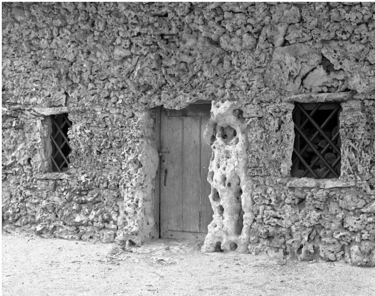
Fabrique de jardin : détail de la mise en oeuvre des matériaux sur la façade antérieure.
