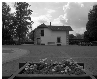
Fabrique de jardin : façade latérale droite.
