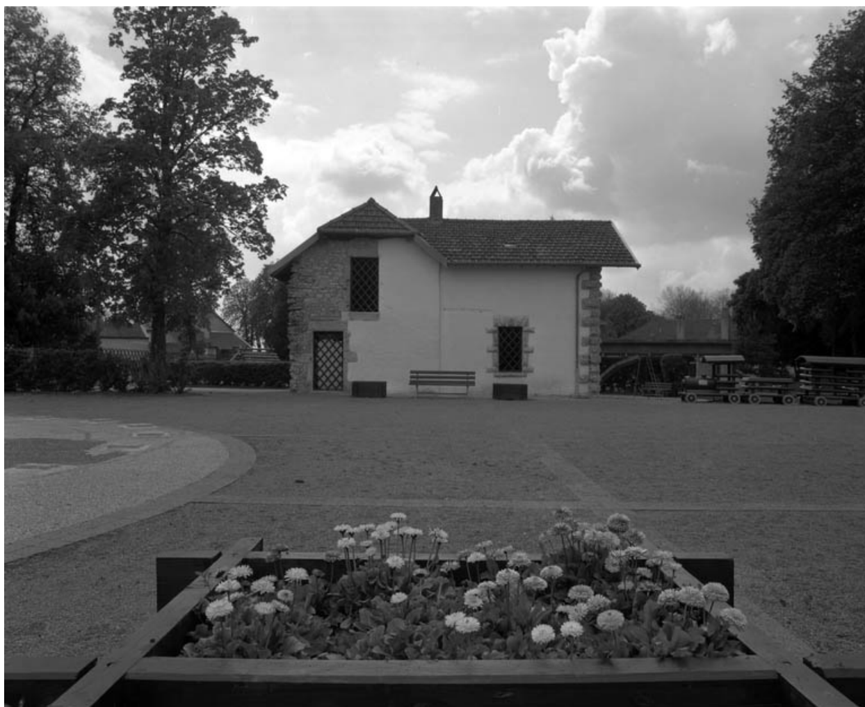
Fabrique de jardin : façade latérale droite.
