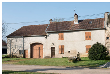
Ferme, rue du Mont. Phot. Jérôme Mongreville IVR43_20177000267NUC4A
