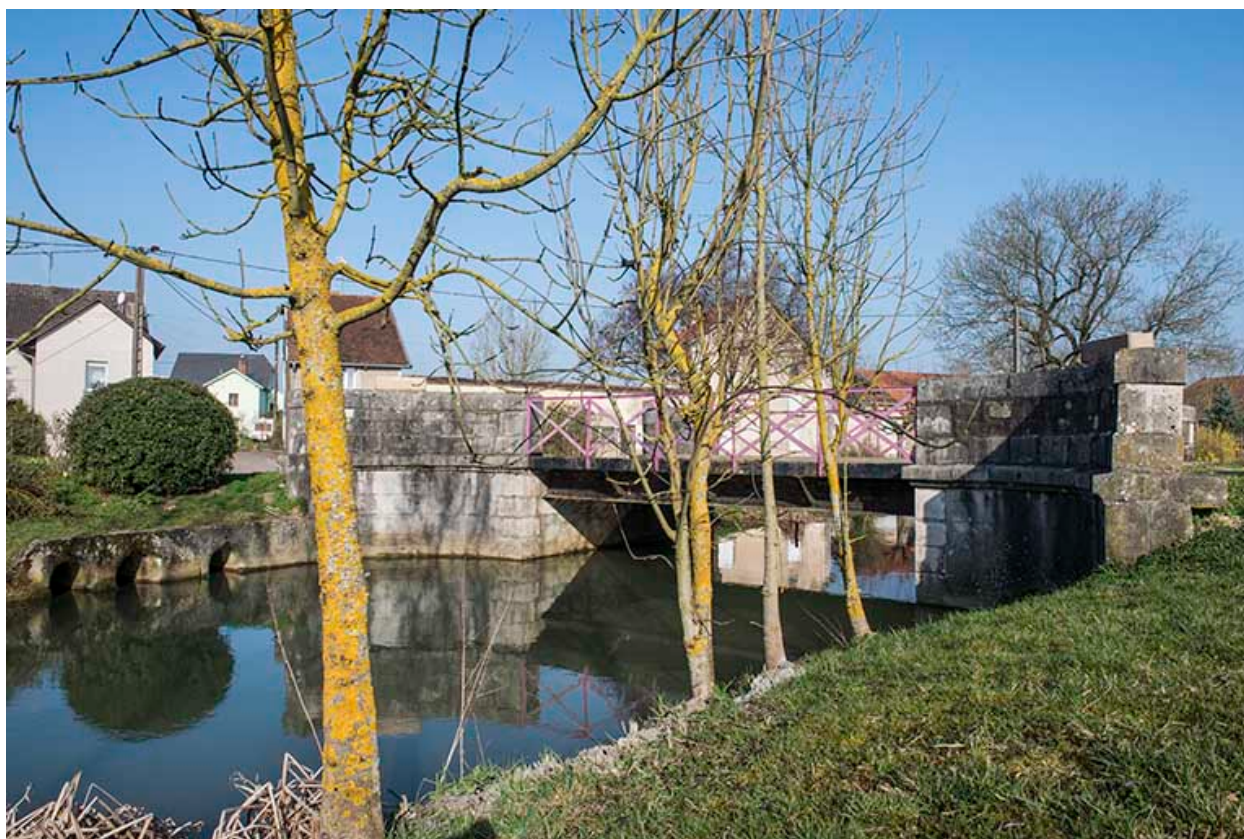
Le pont enjambant le ruisseau.
