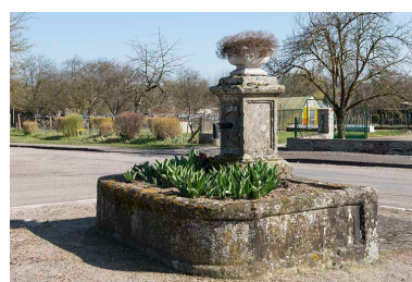
Le bassin maçonné de la fontaine. Phot. Jérôme Mongreville IVR43_20177000254NUC4A
