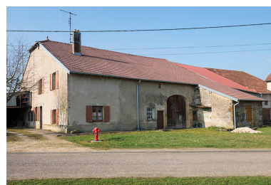
Ferme, rue du Mont. Phot. Jérôme Mongreville IVR43_20177000277NUC4A
