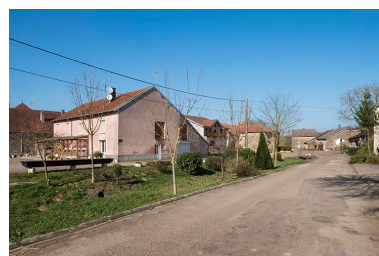
Rue principale. Phot. Jérôme Mongreville IVR43_20177000242NUC4A
