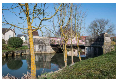
Le pont enjambant le ruisseau. Phot. Jérôme Mongreville IVR43_20177000271NUC4A
