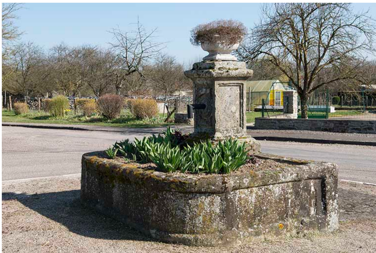
Le bassin maçonné de la fontaine.
