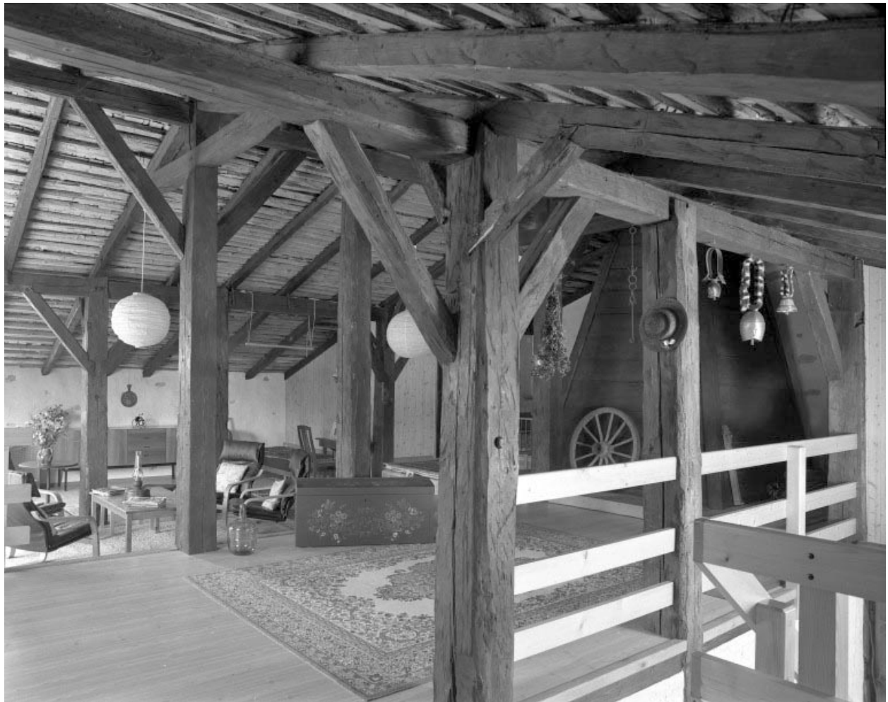
La grange haute : vue générale de la charpente sur poteaux.
