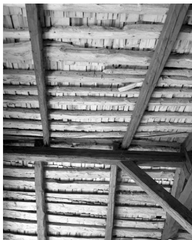
Détail de la couverture depuis la grange haute : les tavaillons
