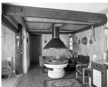
Le départ de la cheminée en bois au rez-de-chaussée. Sur la droite, accroché au mur, on aperçoit l'instrument en bois qui sert à l'ouverture des vantaux de la cheminée.
