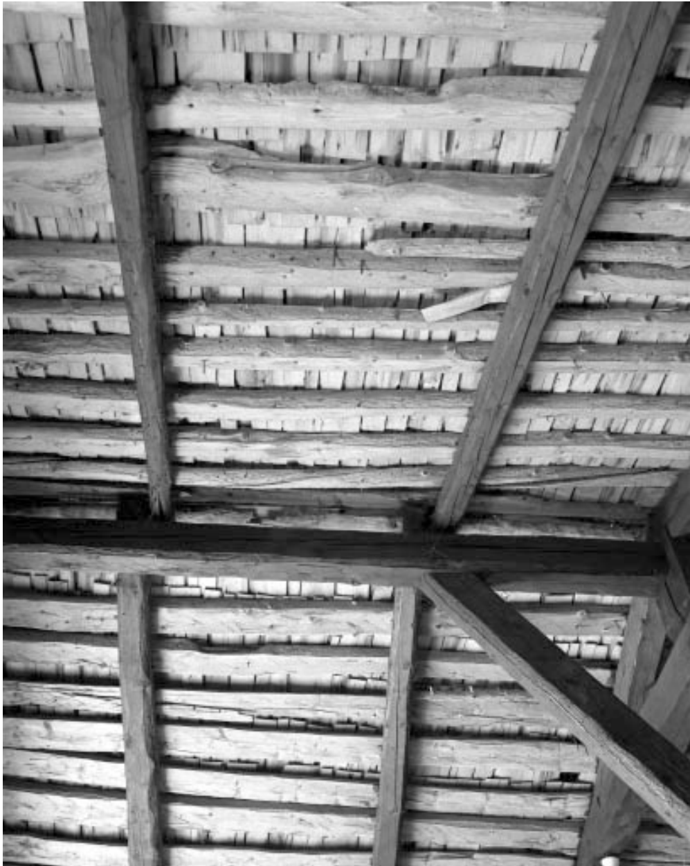
Détail de la couverture depuis la grange haute : les tavillons sont encore posés sous la couverture en tôle actuelle.
