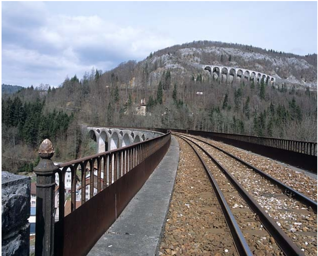
Tablier et garde-corps métallique côté Andelot-en-Montagne.
