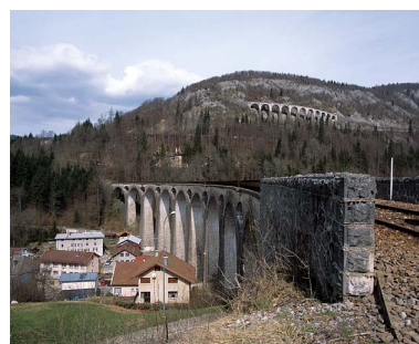
Parapet sud de la culée côté Andelot-en-Montagne. Phot. Yves Sancey IVR43_20053900505XA
