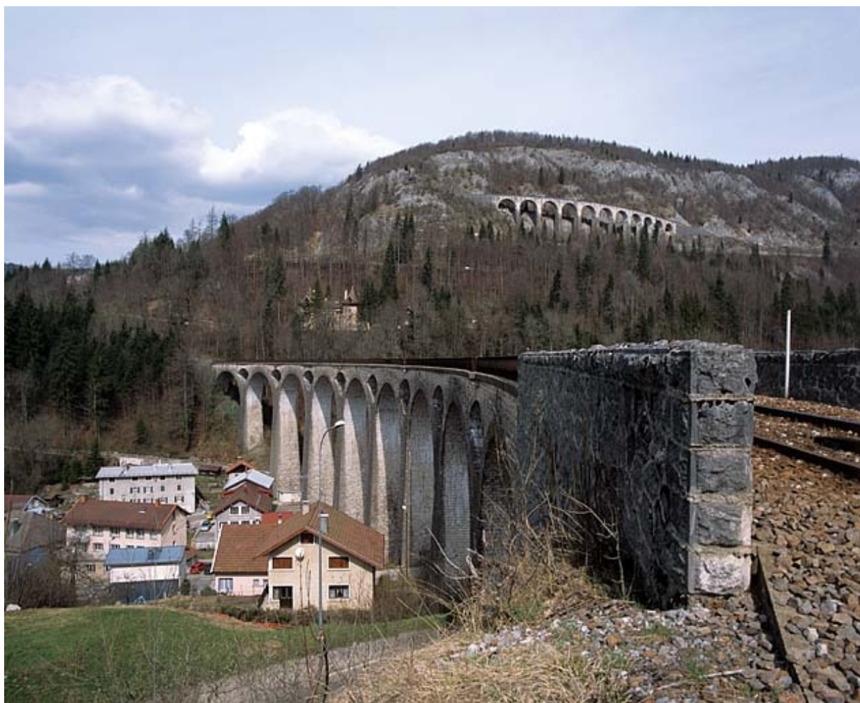
Parapet sud de la culée côté Andelot-en-Montagne.
