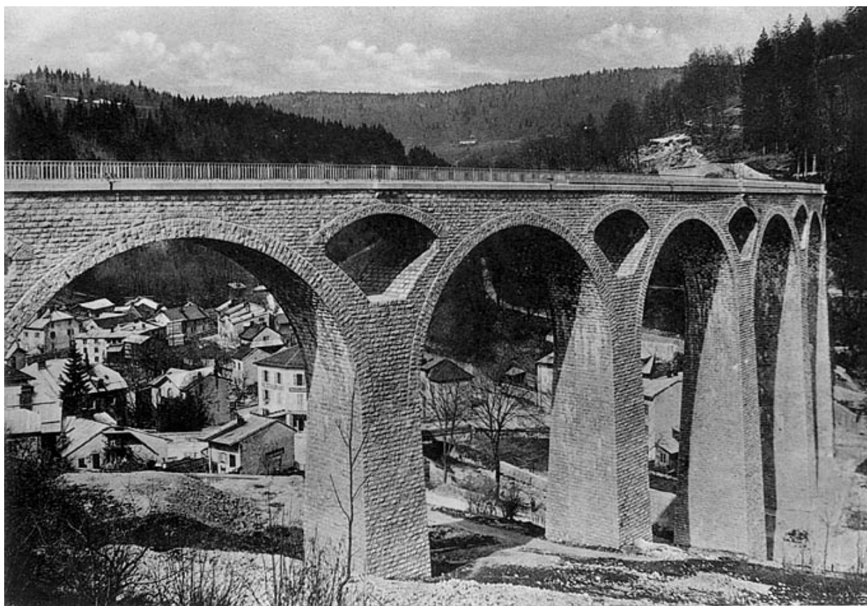
5. — VIADUC DE MOREZ.
