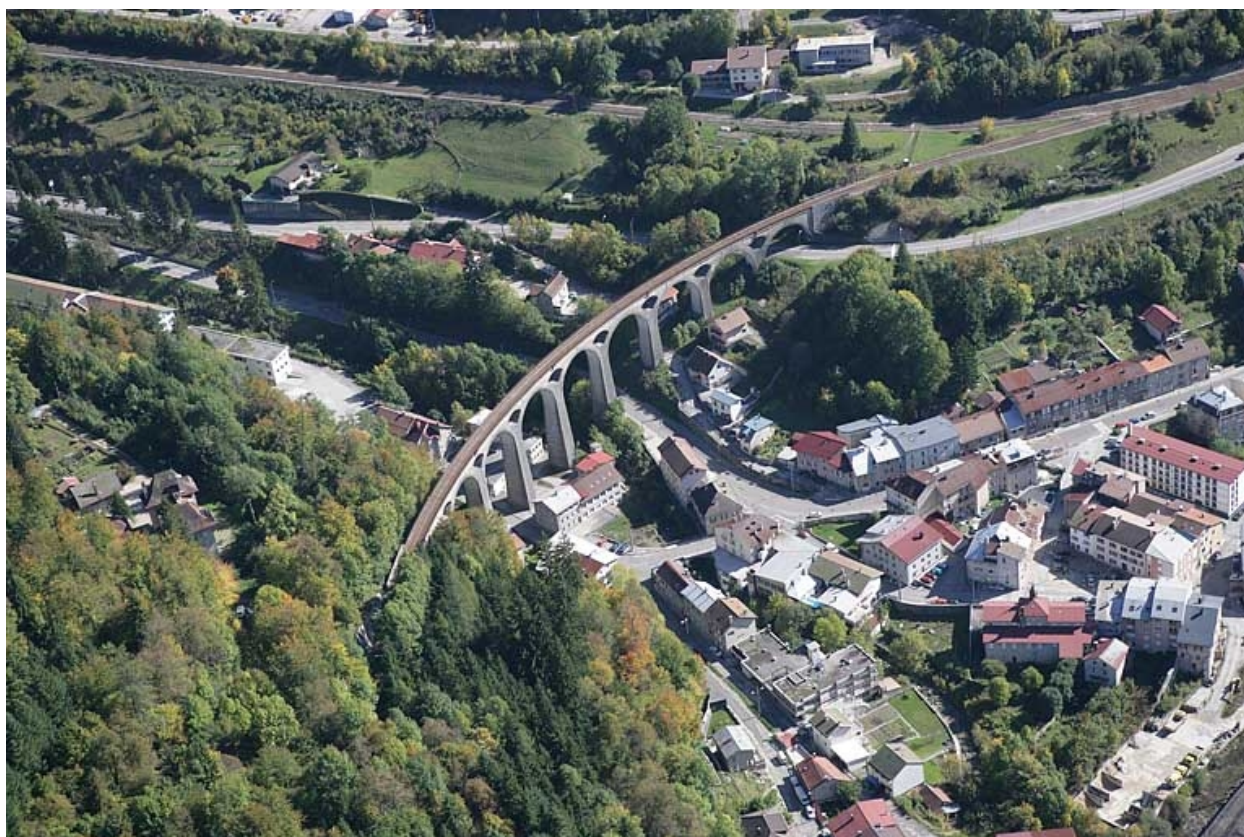
Vue aérienne rapprochée, depuis l'ouest.
