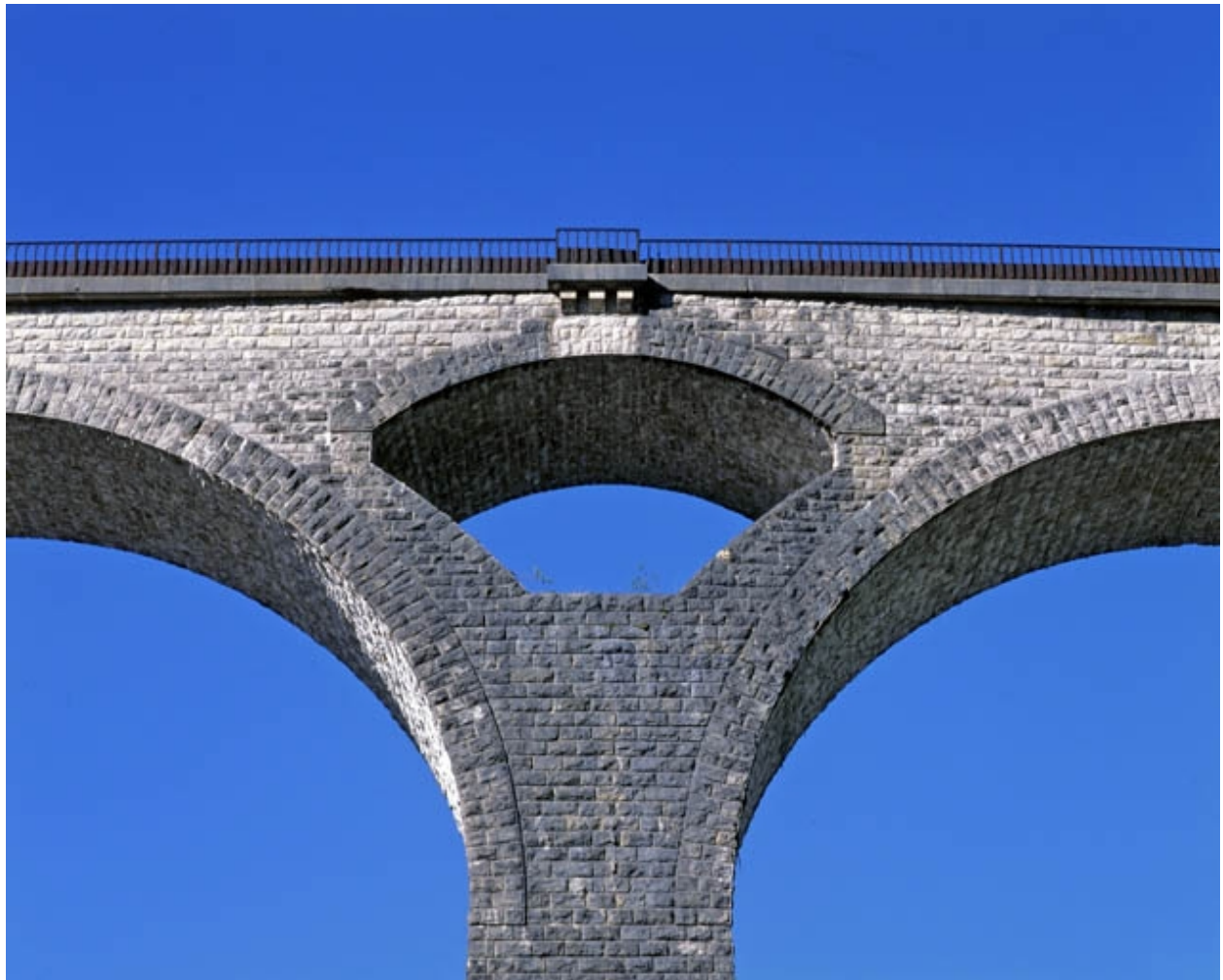
Pile avec voûte d'élégissement et refuge.
