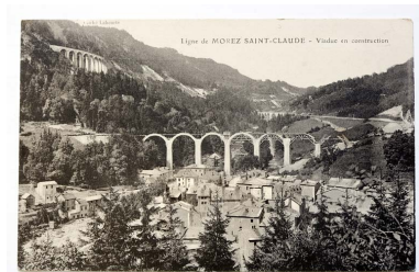
Ligne de Morez Saint-Claude - Viaduc en construction, 1910-1911. Phot. Yves Sancey, Phot. Laheurte IVR43_20073900391NUCA
