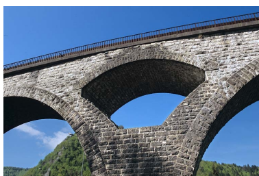
Voûte d'élégissement. Phot. Yves Sancey IVR43_20053900508ZA
