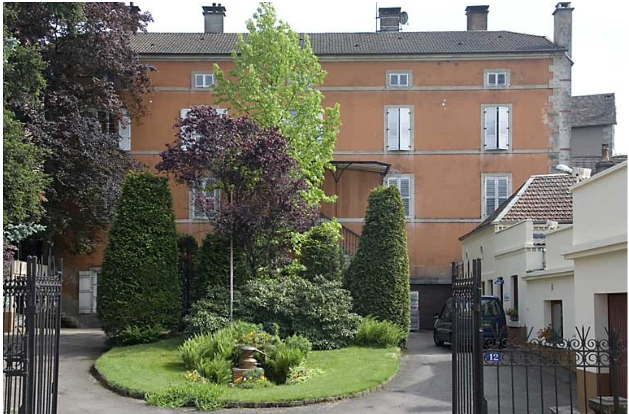
Vue d'ensemble depuis la rue.
