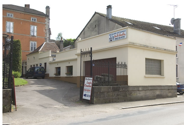
Bureaux et magasin industriel. Phot. Jérôme Mongreville IVR43_20077000135NUCA
