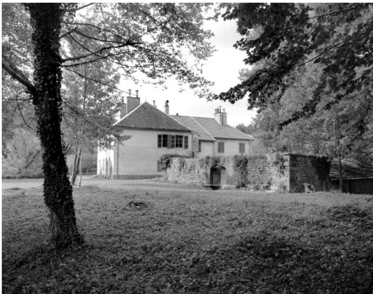
Façade postérieure de l'habitation depuis le parc.
