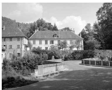
Façade antérieure depuis le pont. Phot. Yves Sancey IVR43_19923901004X
