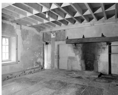
Intérieur de l'habitation : la cuisine. Phot. Yves Sancey IVR43_19923901024X
