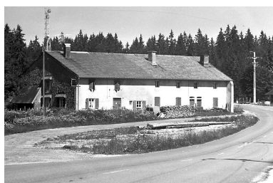
Ferme située au lieudit Joux Dessus. Phot. Jérôme Mongreville IVR43_20003900404X
