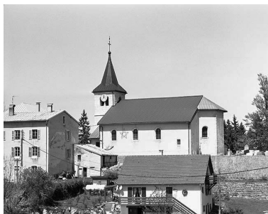
Eglise paroissiale Saint-Barthélémy. Phot. Jérôme Mongreville IVR43_20003900617X
