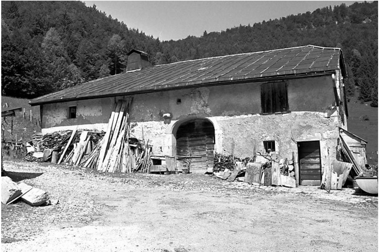
Ferme située au lieudit Près des Arcets.
