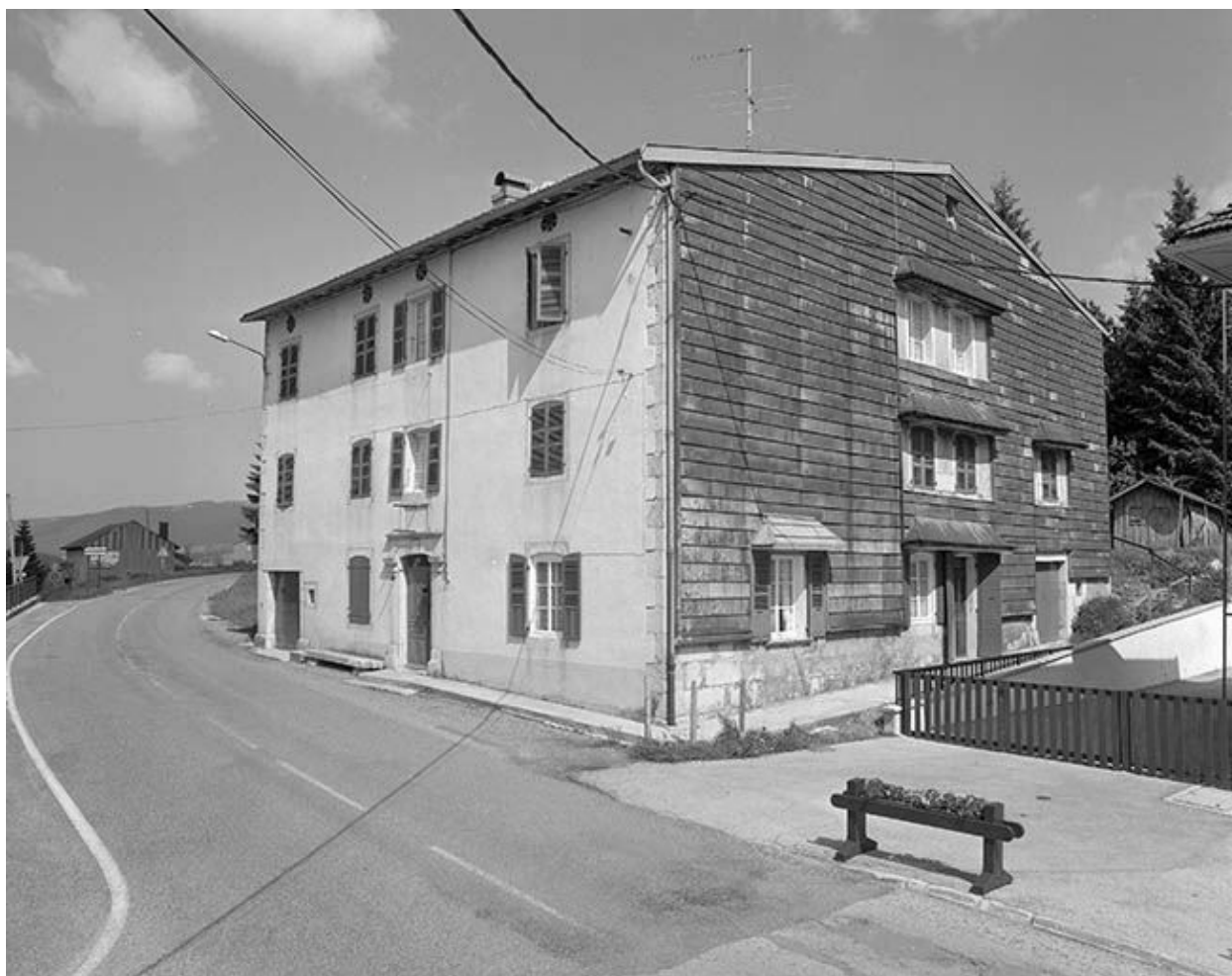
Ferme-café Grenier située rue du Moine Manon.
