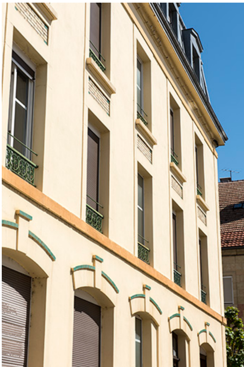
Façade latérale gauche : détail des baies.
