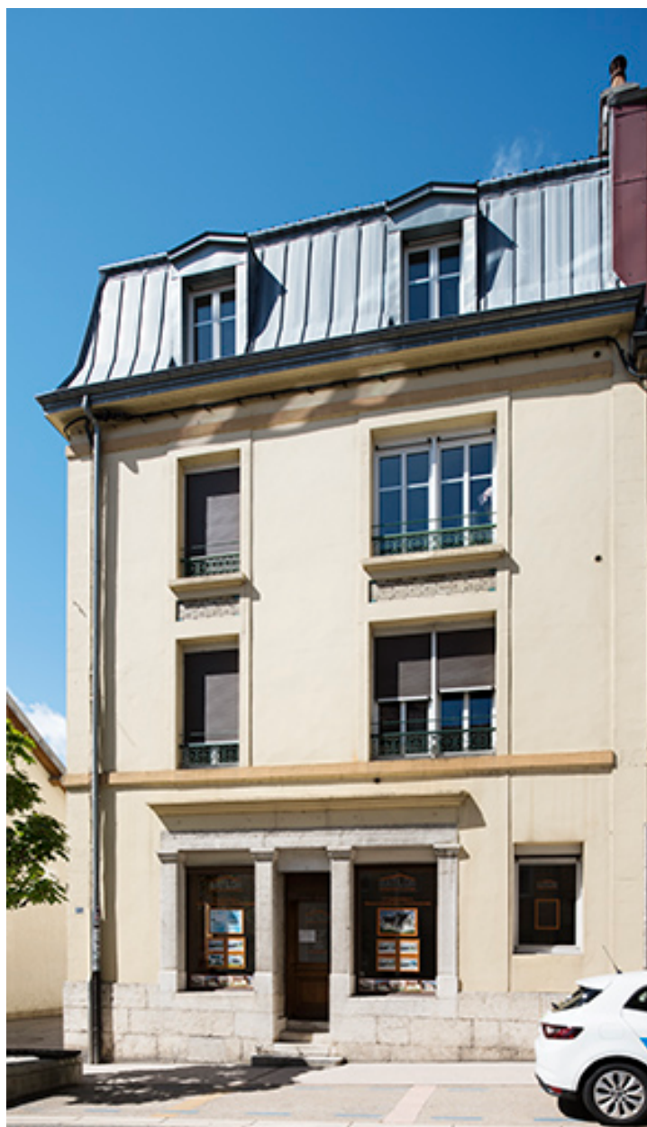
Partie gauche (5 bis) de la façade antérieure.
