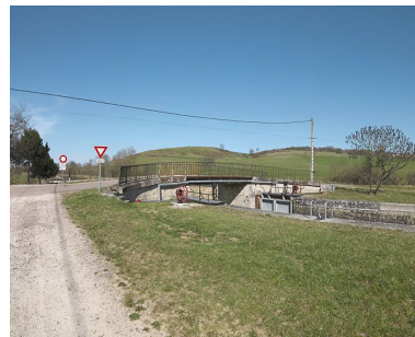
Le pont. Phot. Thierry Kuntz IVR26_20122102736NUC4A
