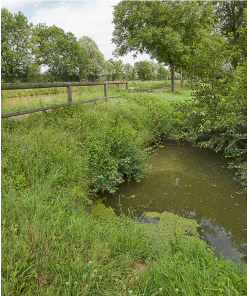
Vue de l'aqueduc.
