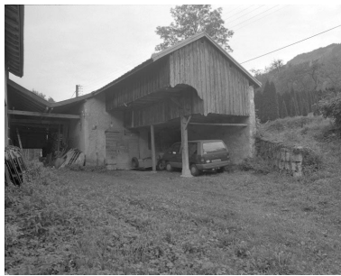
Vue de la remise qui jouxte la ferme. Phot. Jérôme Mongreville IVR43_19943901081X
