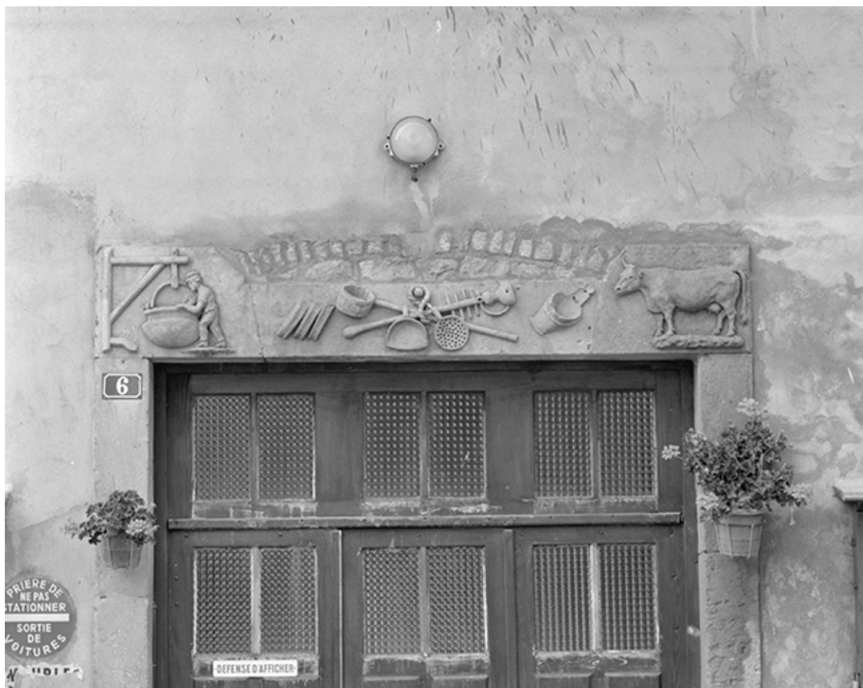
Linteau de la porte d'entrée en 1979.
