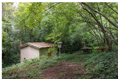
Vue d'ensemble. Phot. Fabien Dufoulon IVR26_20217100104NUC2A
