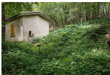
Bâtiment principal. Phot. Fabien Dufoulon IVR26_20217100106NUC2A
