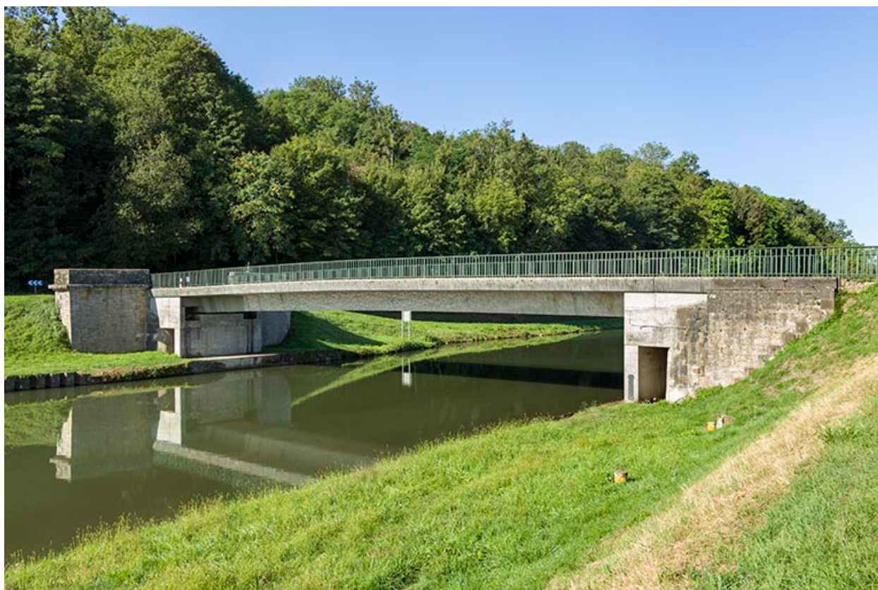
Pont de la D152 enjambant le canal.
