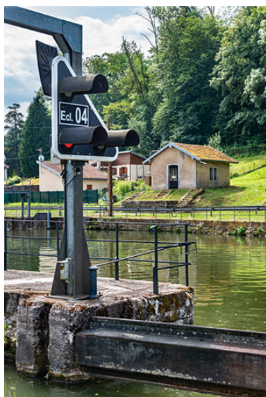
Le panneau de signalisation de l'écluse et le magasin à aiguilles du barrage. Phot. Jérôme Mongreville IVR43_20207000210NUC4A
