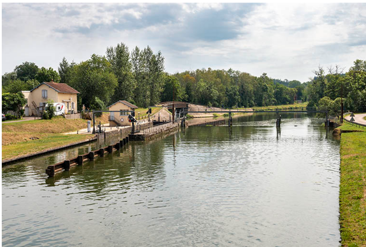
Le site d'écluse.
