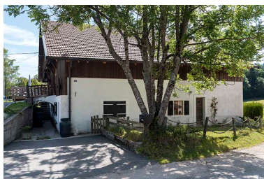
Façade latérale gauche et pont de grange. Phot. Sonia Dourlot IVR43_20172500721NUC4A
