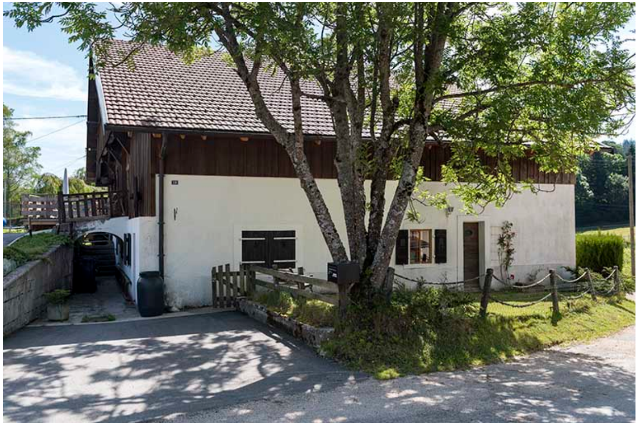
Façade latérale gauche et pont de grange.
