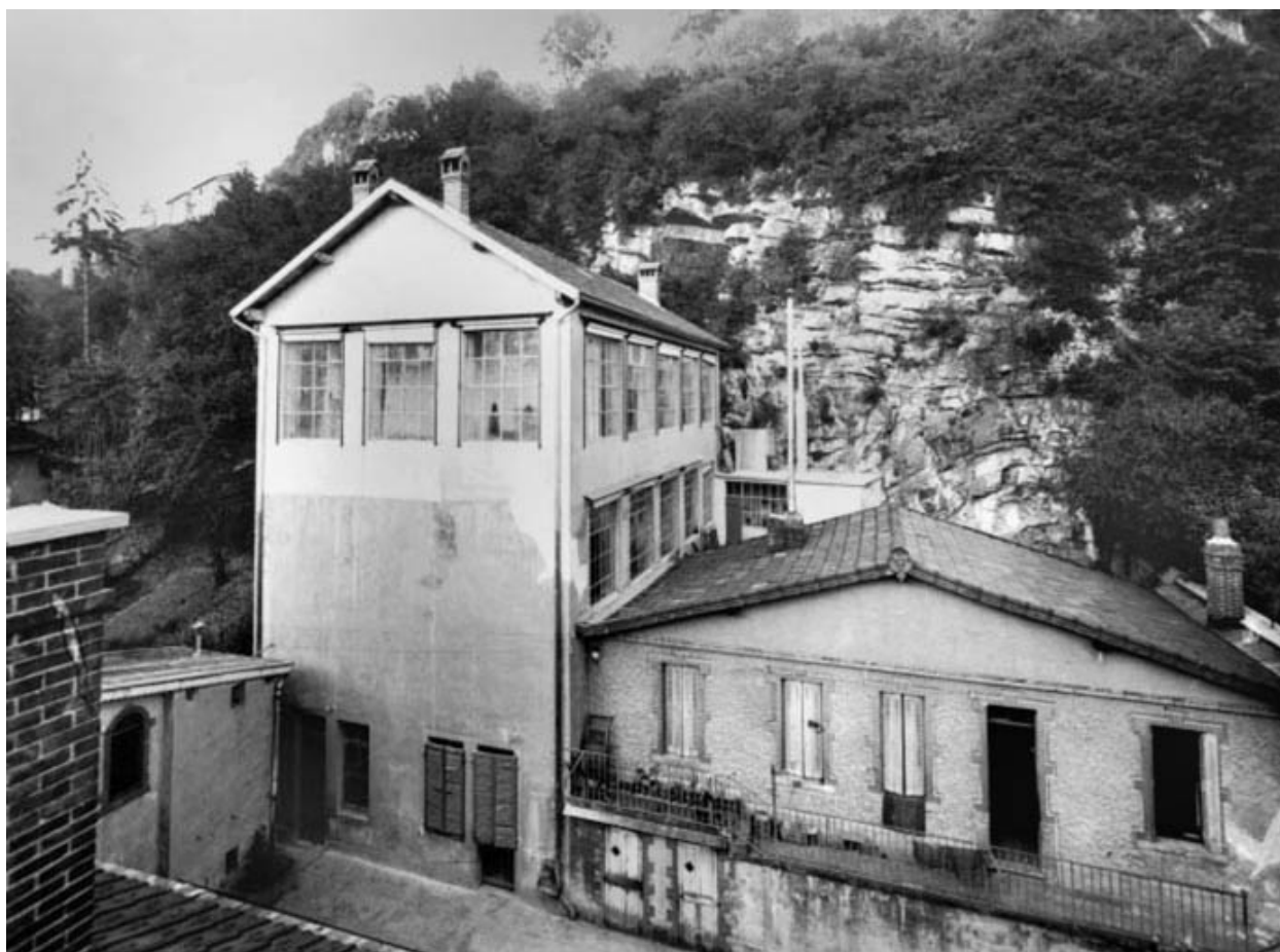
Façade antérieure, milieu 20e siècle.
