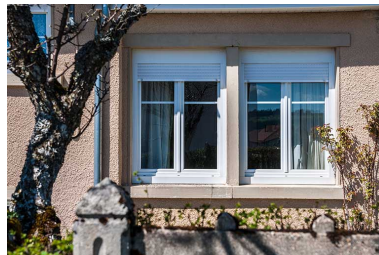
Fenêtres horlogères sur la façade antérieure. Phot. Jérôme Mongreville IVR43_20142500215NUC4A
