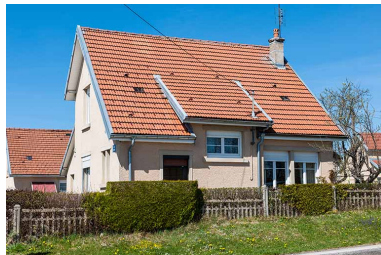
Façade antérieure. Phot. Jérôme Mongreville IVR43_20142500213NUC4A
